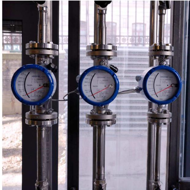
Abb. 3.8: Dreistufige Luftversorgung für AR
