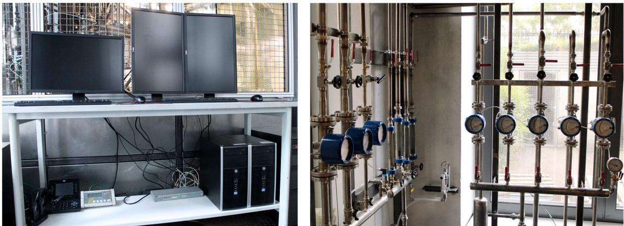
Abb. 4.13: links: Operatorstationen, rechts: Handventile der Reaktorfluidisierungen
