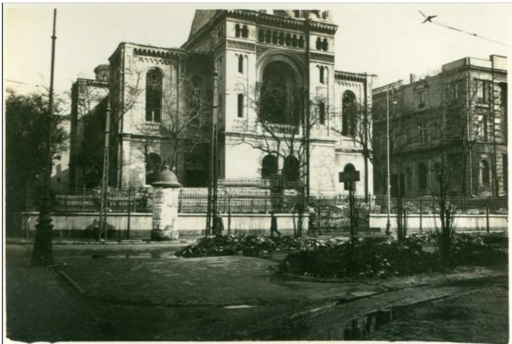
Abbildung 174: Foto der zerstörten Synagoge 1940
