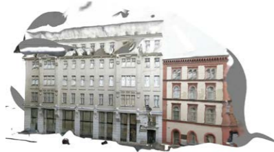
Abb. 4-15: Photogrammetrie der Tempelgasse
