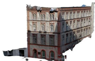
Abb. 4-17: Photogrammetrie des erhaltenen Seitentraktes
