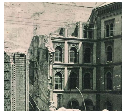
Abb. 2-31: Blendmauer im südlichen Hof
