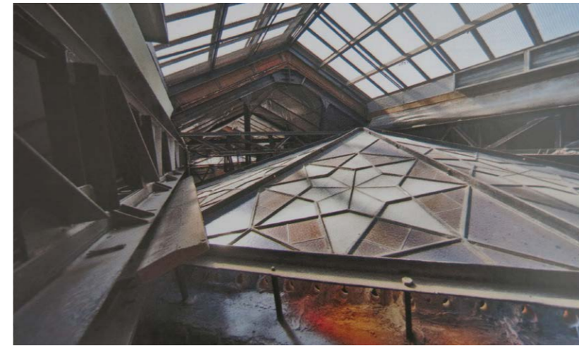
Abb. 2-44: Dachstuhl in Budapest
