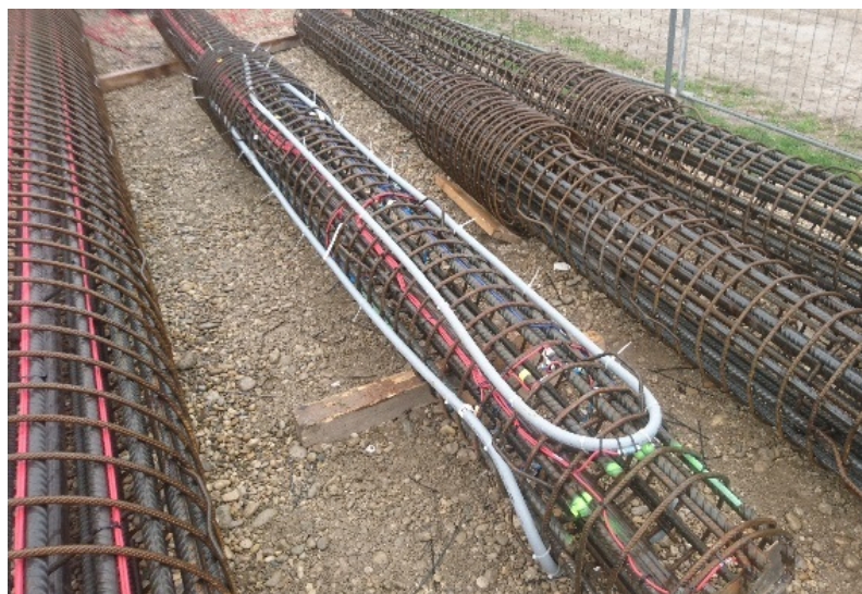
Abb. 4.14: Absorber befestigt am Bewehrungskorb des Kiespfahl B.EK
