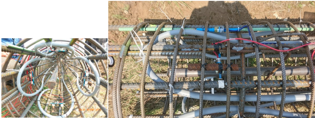
Abb. 4.11: Absorber befestigt auf Bewehrungskorb des Miozänpfahl B.EM
