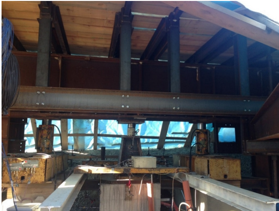
Abb. 4.24: Pressen links und rechts - mittig der Pfahlkopf (Miozänpfahl B.EM)
