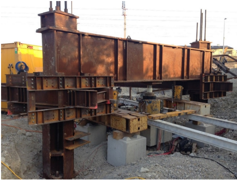
Abb. 4.25: Prüfbalken mit Presse (Kiespfahl B.EK)
