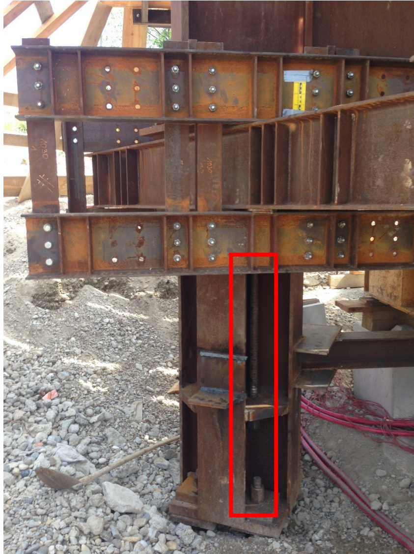
Abb. 4.20: Verbindung Stahlträger- Reaktionspfahl
