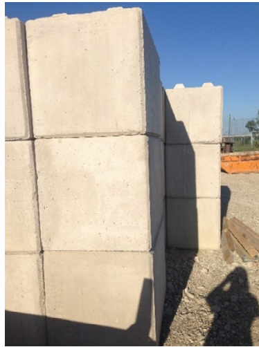
Abb. 4.22: Betonbloxx auf der Baustelle
