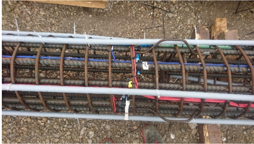
Abb. 4.15: Absorber befestigt am Bewehrungskorb des Kiespfahl B.EK
