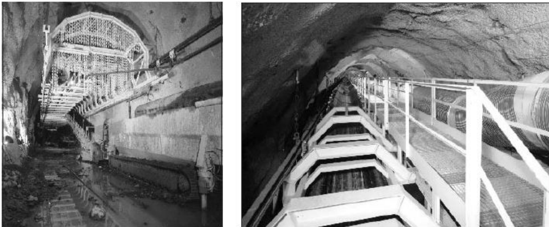
Abb. 5.9: Trümmerschutz durch einen Kettenvorhang (links), Aufgehängte Plattform: Blick auf Lutte, Förderband und Fußweg (rechts) [34]
