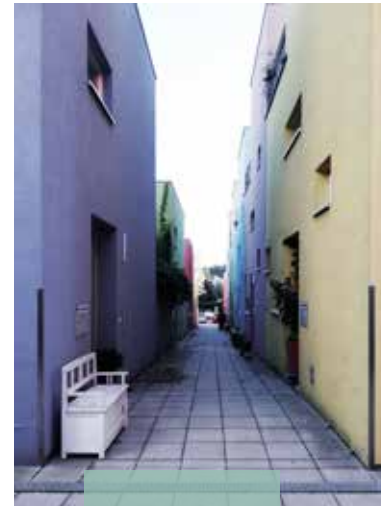
Dichte Reihenhausbebauung im Süden des Kabelwerks
