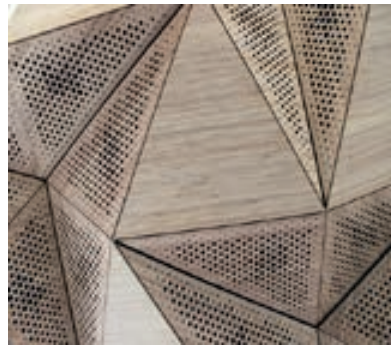
Abb. 73 Beispiel Holz Akustik Elemente
