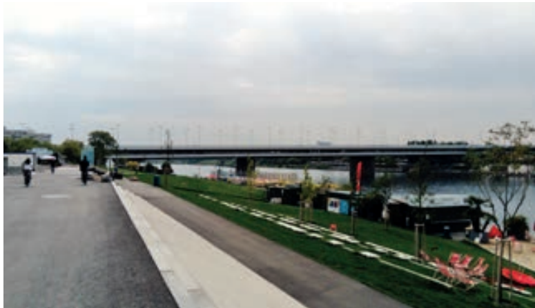
Uferpromenade Blick Richtung Süd-Ost
