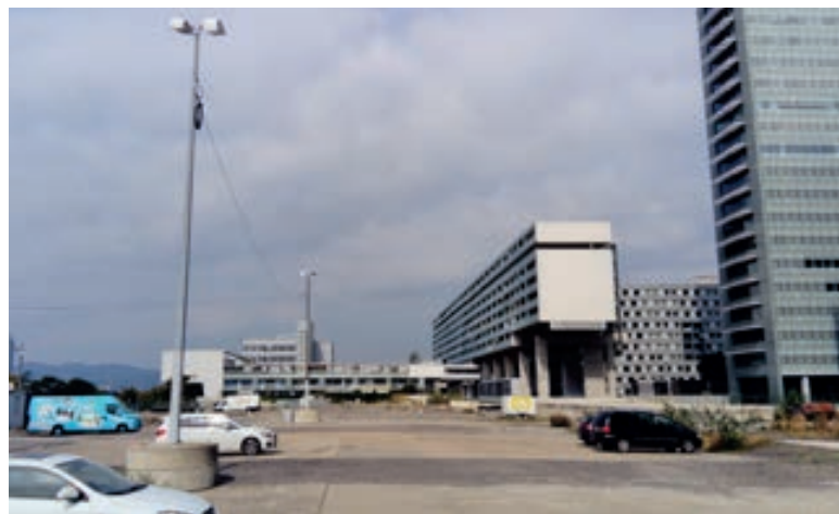
Ufergrundstück Blick Richtung Nord-West
