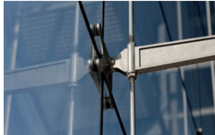
Abb. 66 Beispiel zur Punkthalterung der äußeren Fassade
