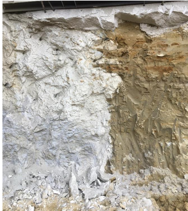
Abb. 2.2: DSV-Block und unbehandelter Boden 13
