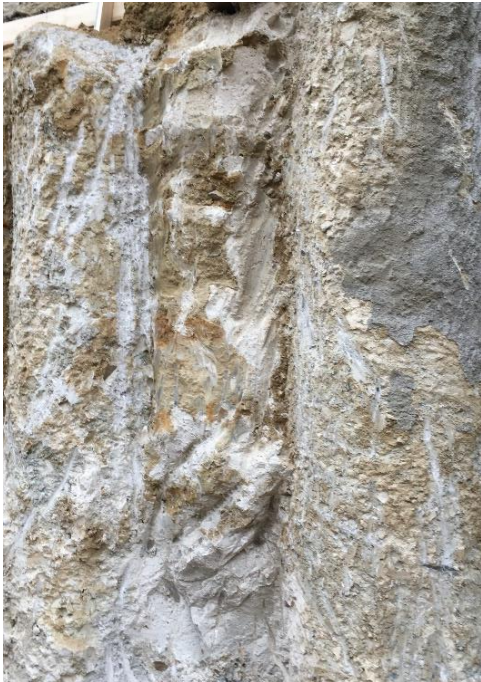
Abb. 2.1: DSV-Zwickel zwischen Bohrpfählen 13
