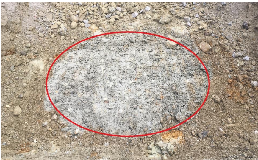
Abb. 2.15: Freigelegte „frische“ Probesäule (bestehend aus zwei nebeneinander gejeteten Säulen) 60
