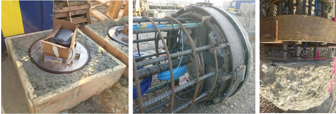
Abb. 6.19: Montagevorbereitungen Sohldruckmessdose [76]
