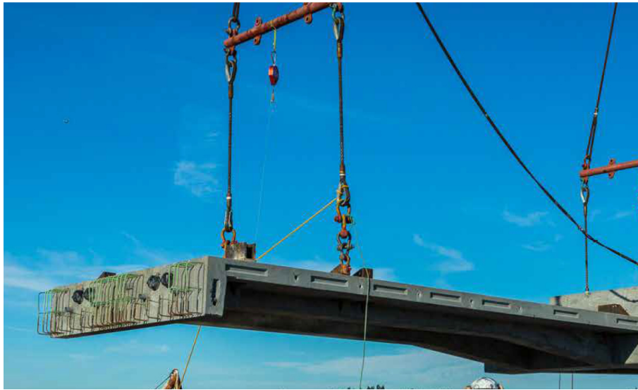
Abbildung 2-13: Betonfertigteil Fahrbahnplatte (Washington State Department of Transportation, 2017)
