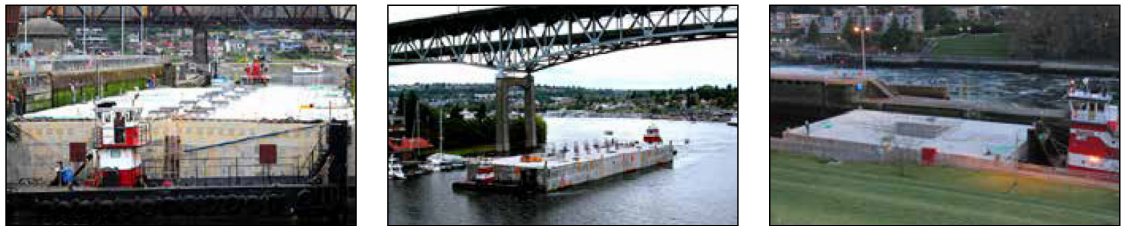
Abbildung 2-8: Längspontons (Links), Querpontons (Mitte), Stabilisierungspontons (Rechts) (Washington State Department of Transportation, 2017)
