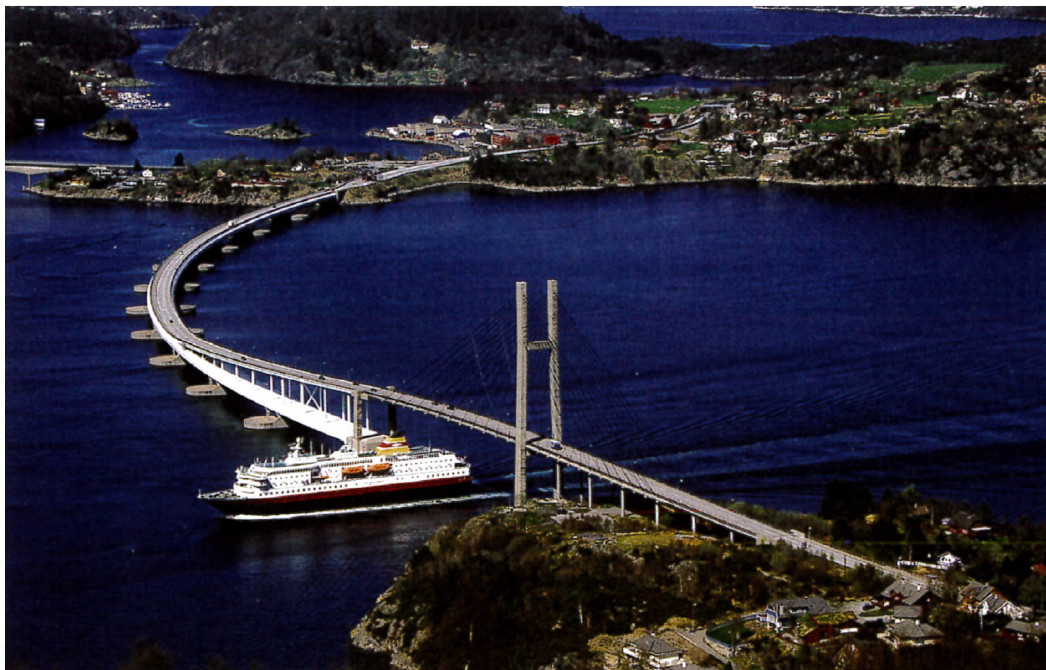
Abbildung 2-19: Nordhordland Brücke (Aas-Jakobsen, 2005)
