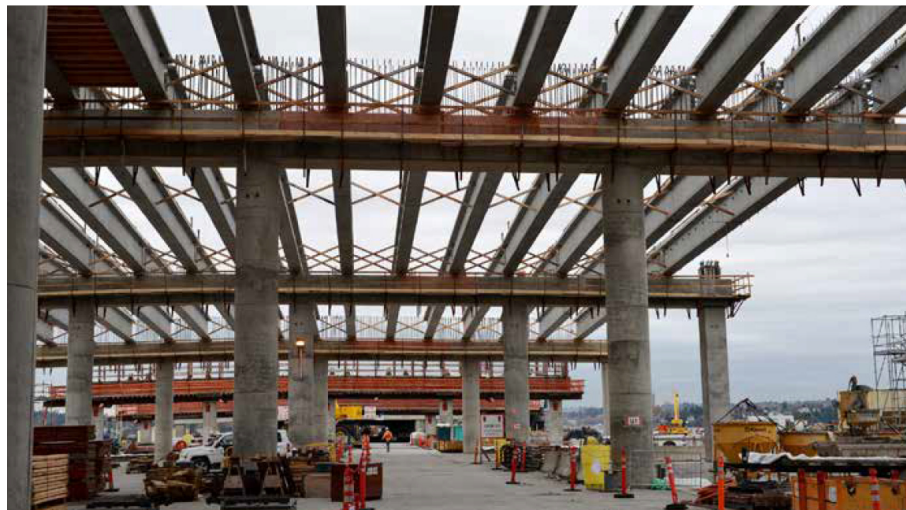
Abbildung 2-14: Betonstützen und –träger (Washington State Department of Transportation, 2017)
