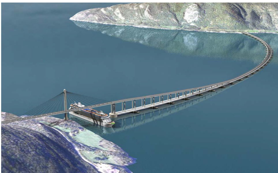
Abbildung 2-24: Schwimmende Pontonbrücke mit Schrägkabelbrücke (Ellevset & Skorpa, 2011)
