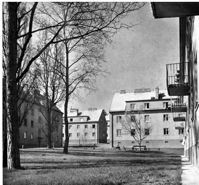
Abb. 13.4: Foto der Liegenschaft Siemensstraße aus dem Jahre 1960 [5]
