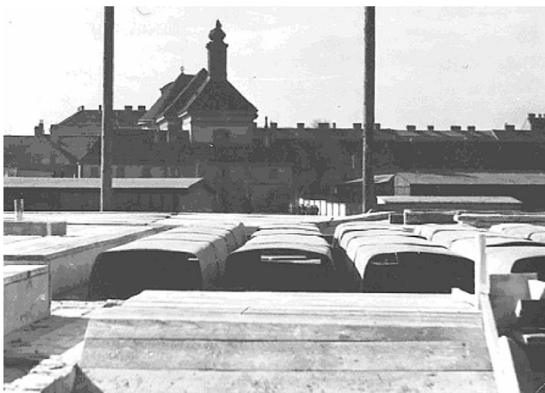
Abb. 8.23: Ast-Molin Deckenschalung auf der Baustelle. [30]
