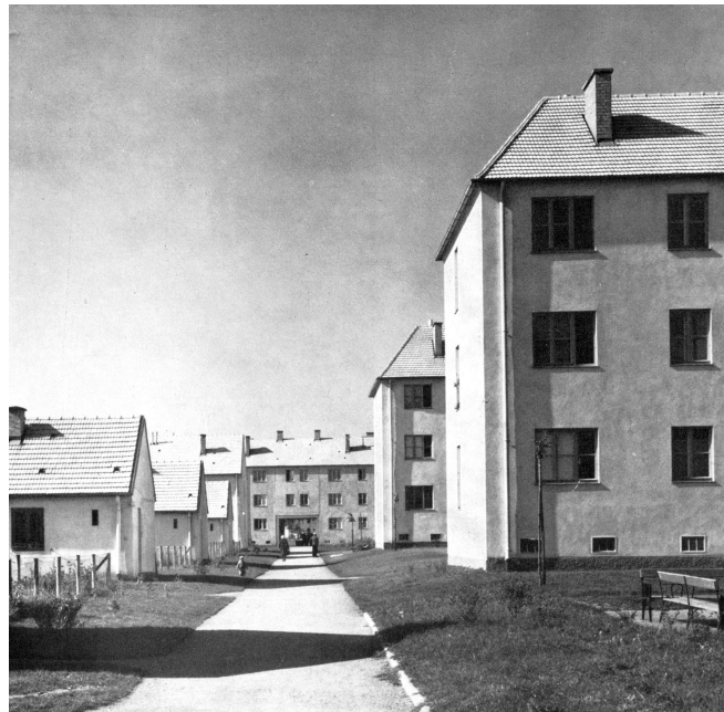
Abb. 13.3: Foto der Liegenschaft Siemensstraße aus dem Jahre 1960 [5]
