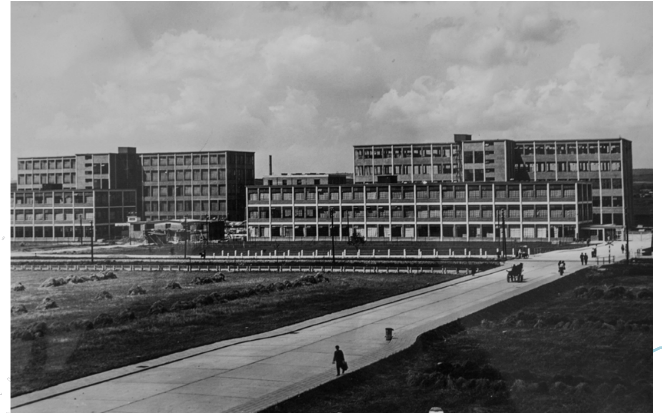
Abb. 69 Promenade führt zum Fabrikareal, erste vier Fabrikbauten und das Kraftwerk
