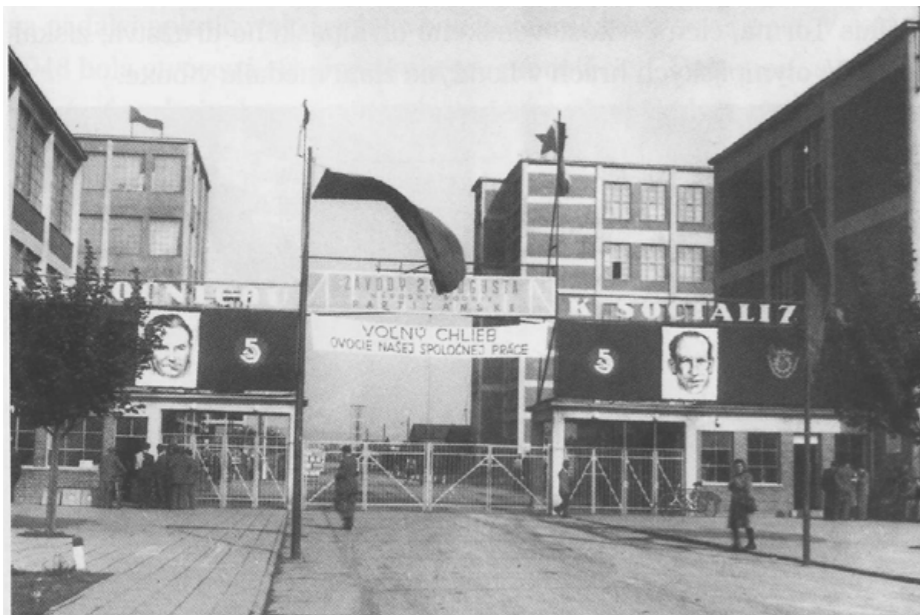
Abb. 96 Eingangstor Werke des 29.Augusts, 1949
