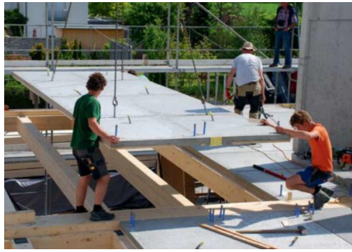
Abbildung 4.5: Montage einer Fertigteilplatte mit FT-Verbindern auf einer Balkenlage [39]
