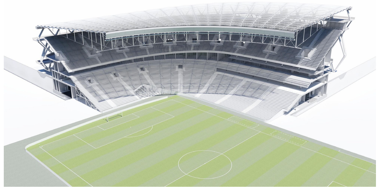
Abb. 6.27 Variante Fußball - Unterkonstruktion
