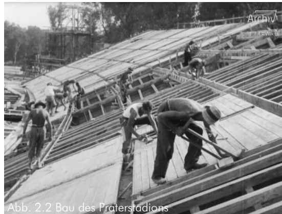
Abb. 2.2 Bau des Praterstadions
