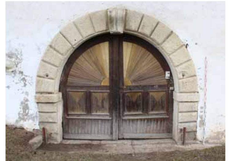
Abb.75: Straßenseitiges Tor im Westtrakt (Türk, 27.03.2018)
