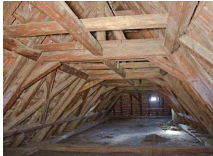
Abb.47: Dachwerk im südwestlichen Gebäudeteil (Türk, 10.04.2018)
