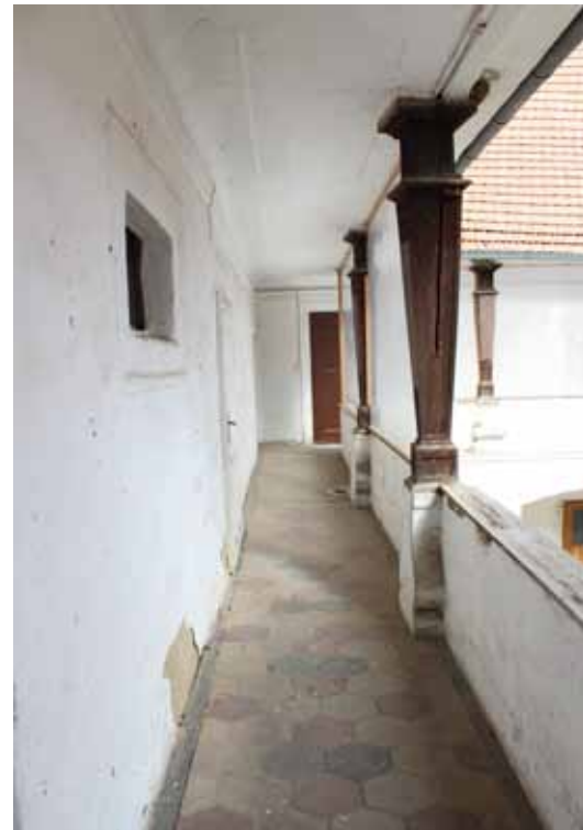
Blick Richtung Norden
