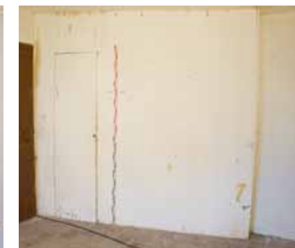
Wand Ost zu EG_09 (Installationen)
