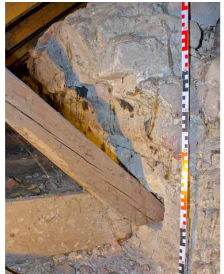
Abb.44: Gesimse in der Nordwestecke des Innenhofs (Türk, 09.04.2018)
