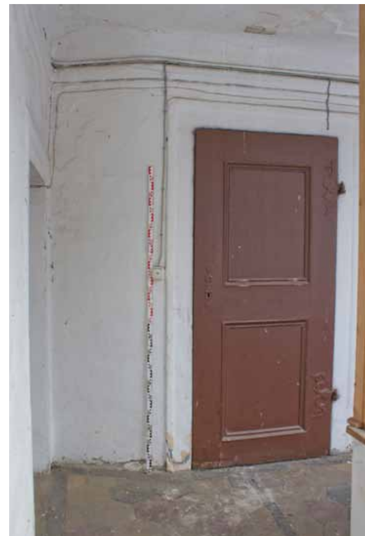
Abb.107: Verschiedene Steinrahmenhöhen in Nordwestecke (Türk, 30.03.2018)
