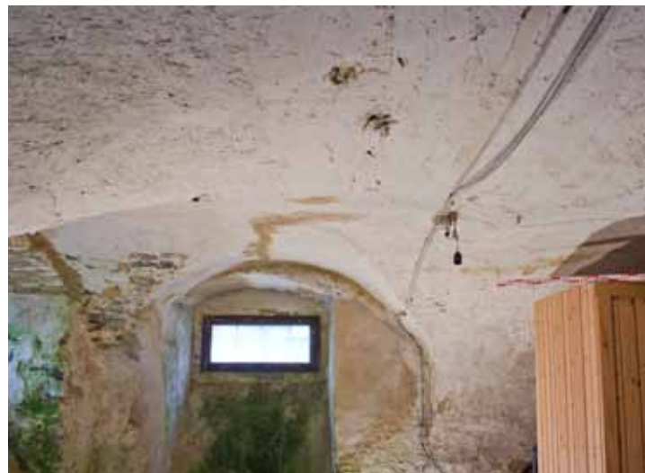
Abb.101: Schalungsgewölbe in EG_01 (Türk, 26.03.2018)
