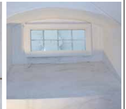
Südfenster zu Innenhof (Stiege)
