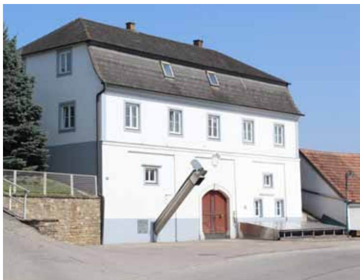
Abb.29: Ehemaliger Schlosskeller nach Aufstockung (Türk, 11.04.2018)
