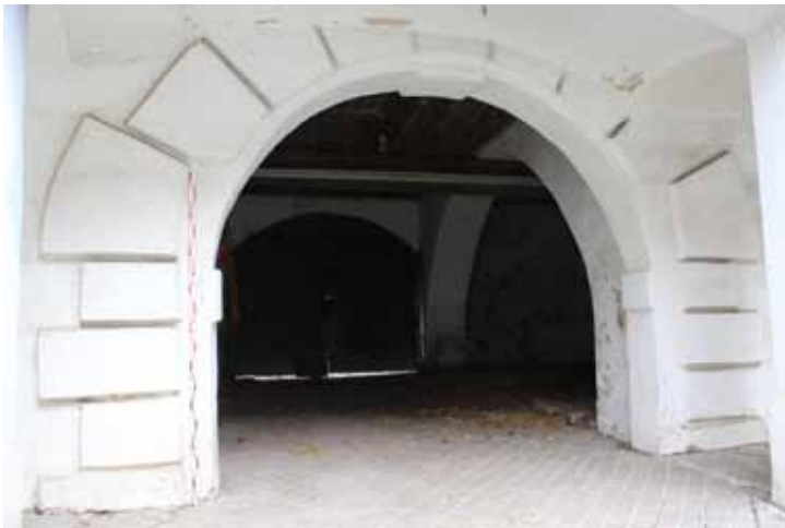
Abb.108: Torbogen vom Innenhof zur Durchfahrt (Türk, 26.03.2018)
