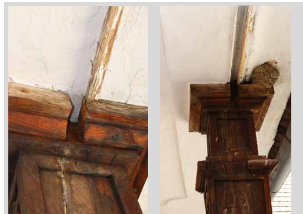
Arkade Südlicher Flügel, Sekundärer Kapitellabschluss mit Ausnehmung für Verglasung und Deckenleisten
