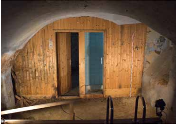
Abb.175: Westwand von EG_02 mit Dusche (Türk, 26.03.2018)
