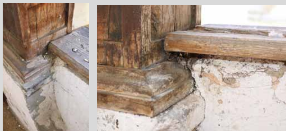
Sekundäre Anschlüsse an die älteren Arkadenpfeiler
