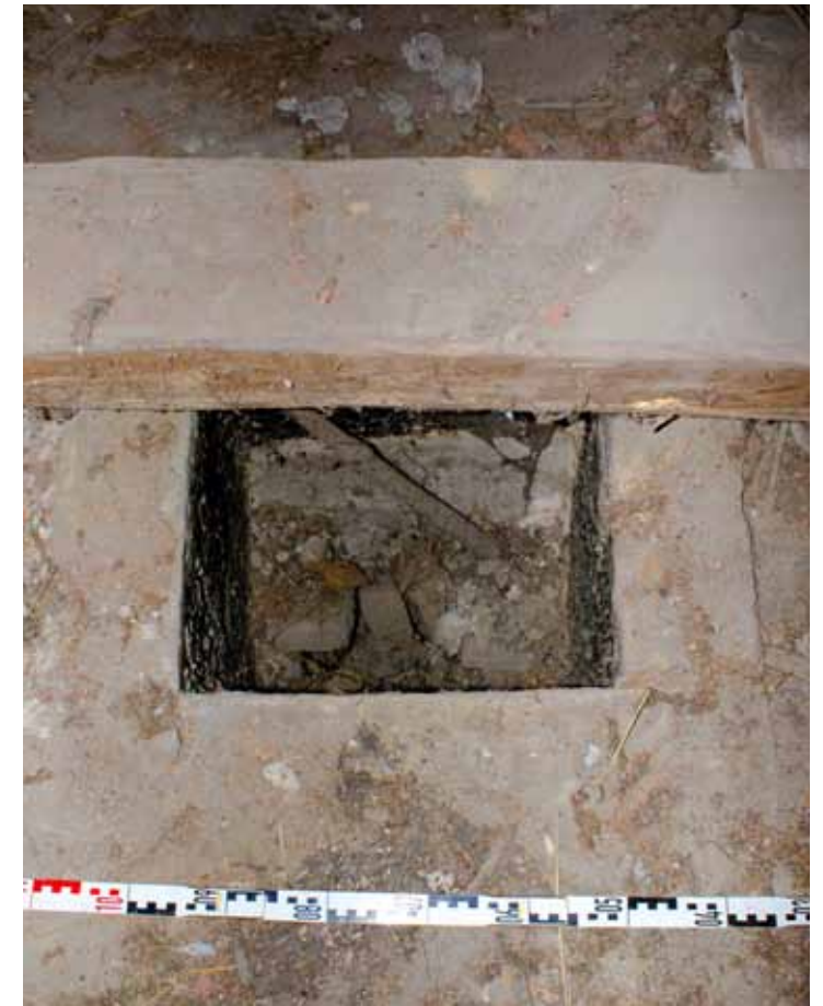
Abb.43: Lüftungsöffnung zu OG_04 (Türk, 09.04.2018)
