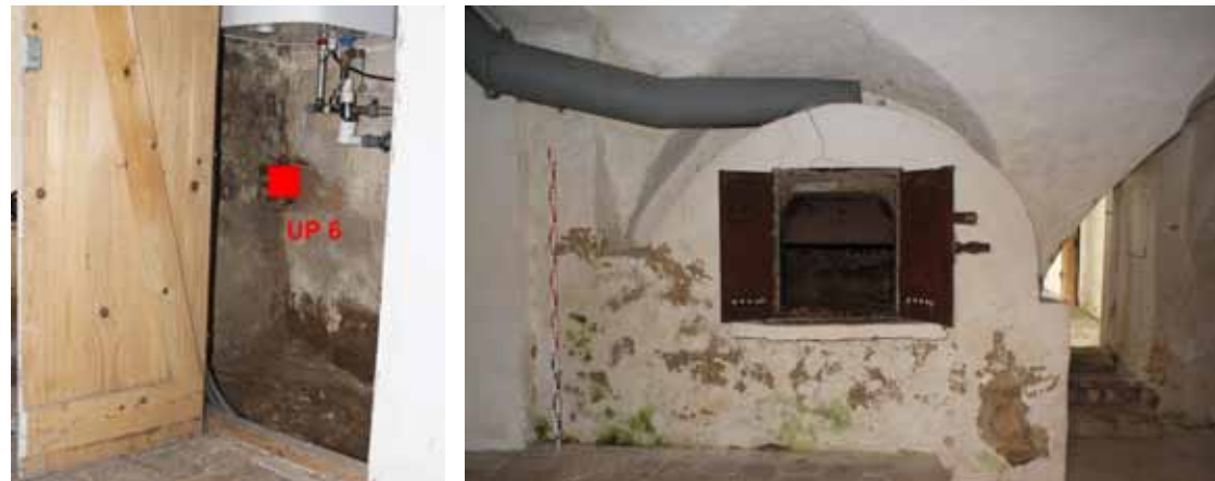
Wand Ost zu EG_19 (Installationen)
