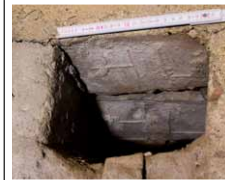
Ziegelprägungen über Außentür
