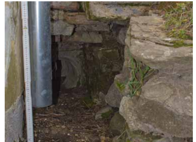
Abb.76: Entwässerung in der südöstlichen Gebäudeaufsenecke (Türk, 27.03.2018)
