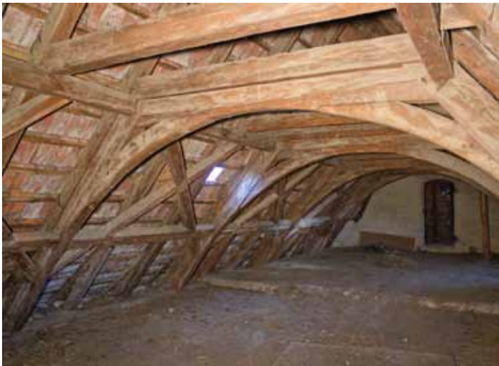
Abb.46: Dachwerk im südöstlichen Gebäudeteil (Türk, 10.04.2018)
