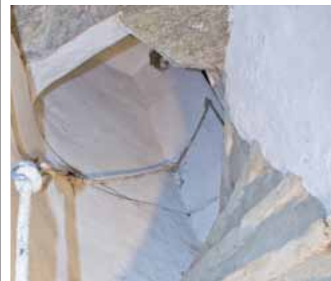
Wand Nord und Wand Ost
