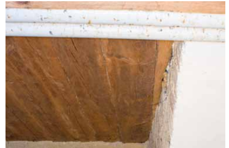
Abb.120: Eingekeilte Dippelbaumdecke in EG_10 (Türk, 28.03.2018)
