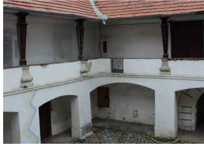
Abb.176: Nordöstlicher Laubengang mit Aufzugsanlage (Türk, 29.03.2018)
