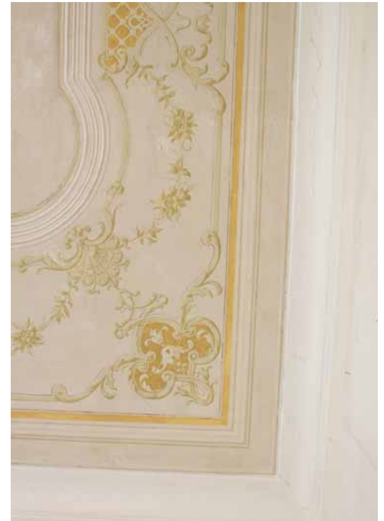
Abb.144: Stuckdecke mit Malereien in OG_05 (Türk, 30.03.2018)
