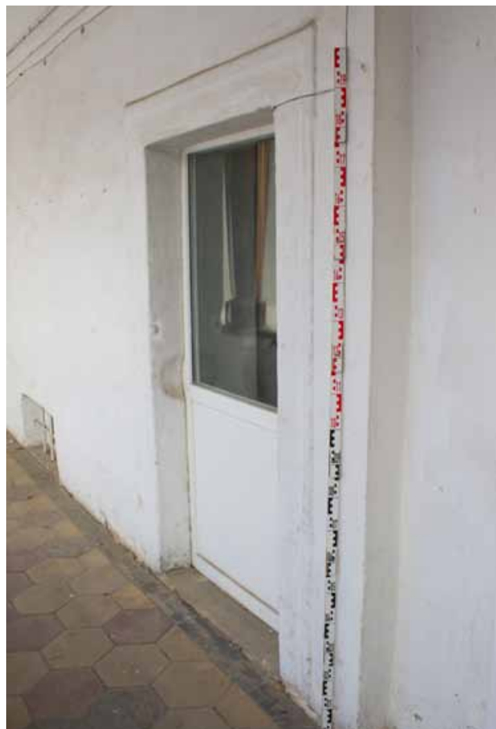
Abb.106: Frühere Türöffnung zum Laubengang von der Nordstiege (Türk, 30.03.2018)
