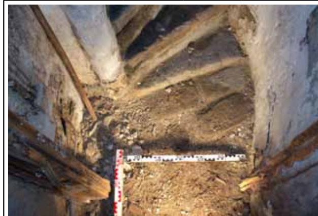
Boden und Antritt zu Wendeltreppe
