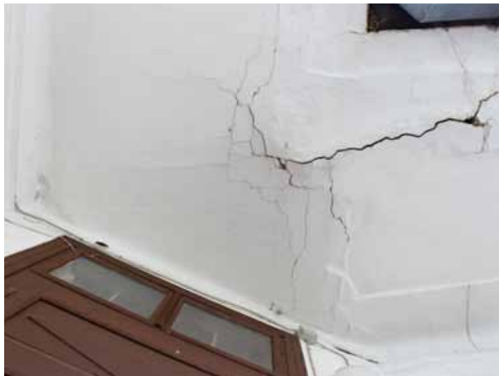
Abb.88: Decke des Laubgangs in der südöstlichen Innenhofecke (Türk, 30.03.2018)
