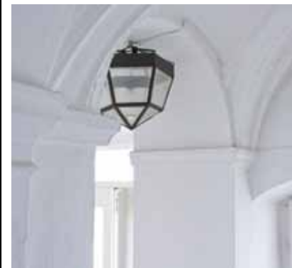
Öffnung in Zwischenwand
