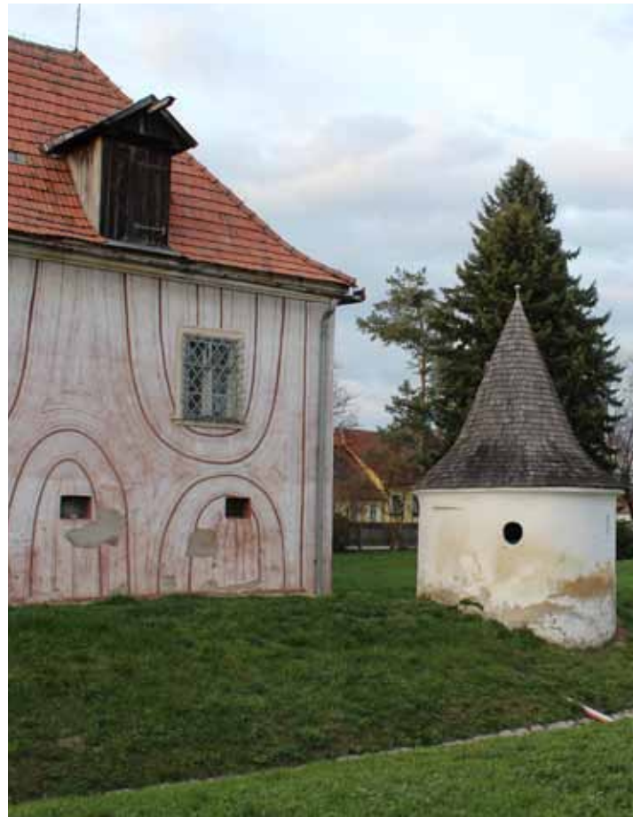
Abb.42: Giebelöffnung in der südöstlichen Gebäudeecke (Türk, 10.04.2018)
