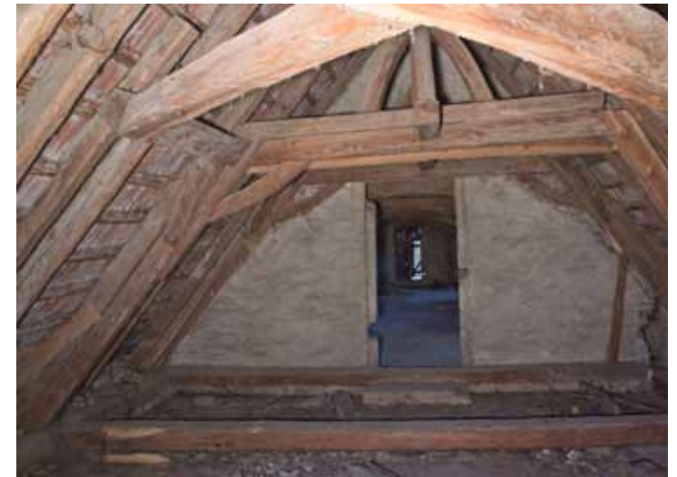
Abb.48: Dachwerk im nördlichen Gebäudeteil (Türk, 10.04.2018)
