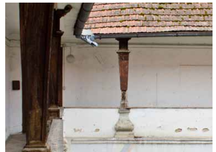
Abb.77: Südöstliche Innenhofecke mit Entwässerung (Türk, 29.03.2018)
