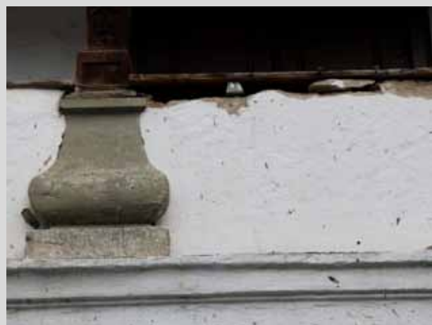
Eingemauerte Holzkeile, Putzspiegel
