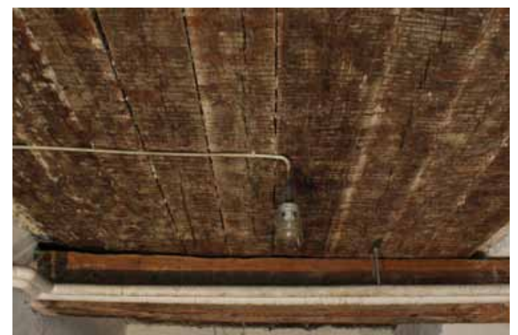
Abb.122: Ehemalig verputzte Holzdecke über der Durchfahrt (Türk, 28.03.2018)
