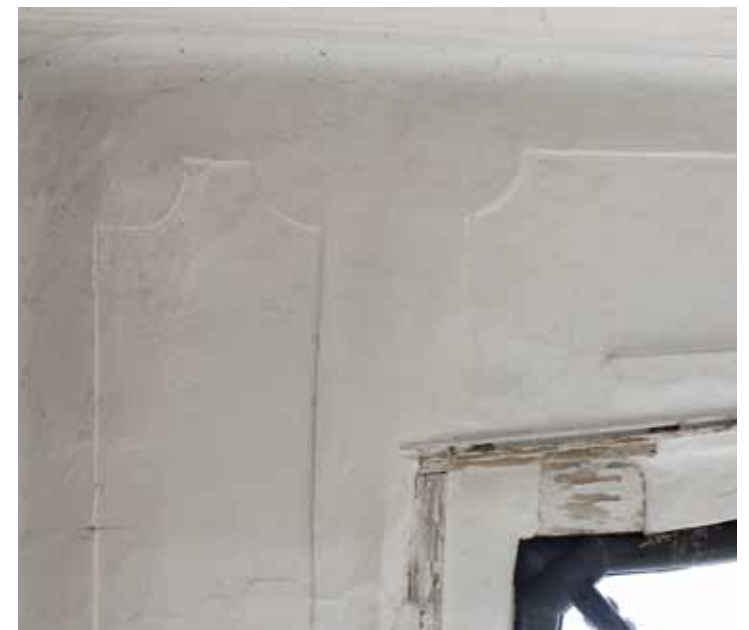
Abb.121: Stuckdecke über südwestlichen Laubengang (Türk, 30.03.2018)
