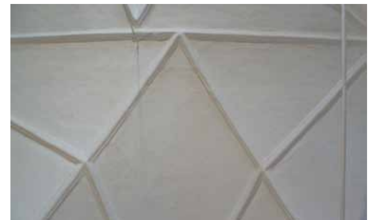
Abb.116: Rippengewölbe in OG_02 (Türk, 30.03.2018)
