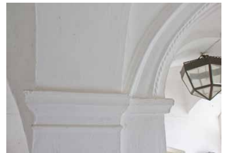
Abb.140: Gesimse beim neuen Stiegenaustritt in OG_01 (Türk, 30.03.2018)
