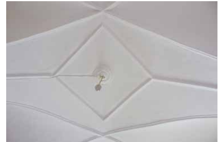
Abb.115: Rippengewölbe in OG_12 (Türk, 31.03.2018)
