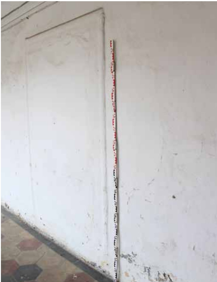
Abb.123: Ehemalige Türöffnung von OG_06 zum Laubengang (Türk, 30.03.2018)
