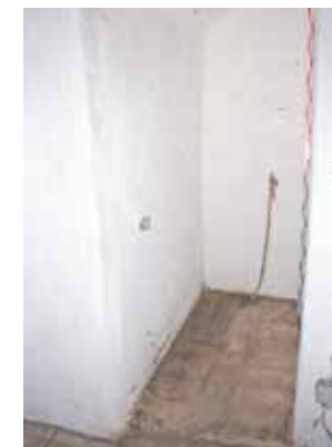
Wand Süd und Wand West
