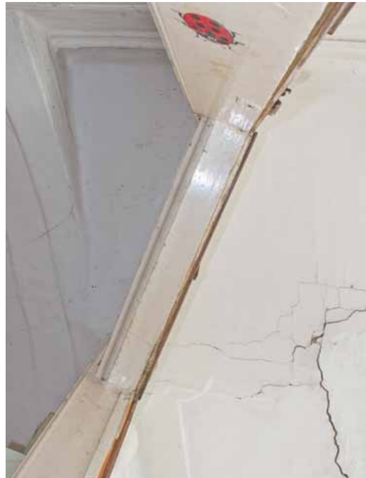
Abb.124: Sekundäre Diagonalwand im südöstlichen Laubengang (Türk, 30.03.2018)
