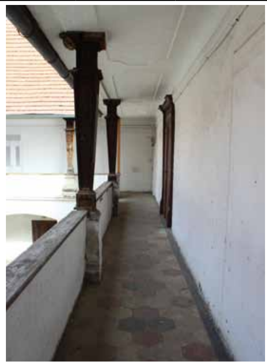
Blick Richtung Norden
