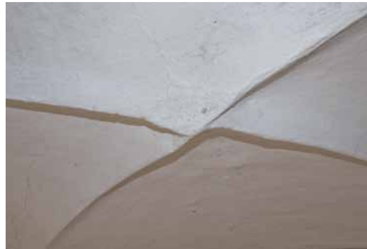
Abb.114: Angeputztes Gewölbe in EG_11 (Türk, 28.03.2018)
