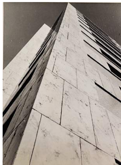
Abb. 199 Kassetierung der Kunststeinfassade mit leicht rückgesprungenen Glasmosaikfelder, 1964
