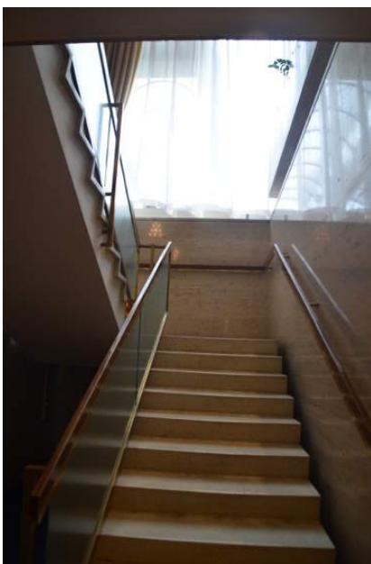
Abb. 232 Stiege ins erste Kellergeschoss aus den 1960er Jahren
