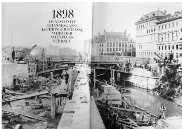
Abb.74 Wien, Verbauung des Wienflusses im Abschnitt Johannesgasse/Lothringerstraße, 1898
