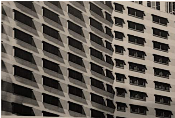
Abb. 196 Original Fensterdetail, Statler Center, Holabird&Root, Los Angeles, 1943, Bildaufnahme 2005
