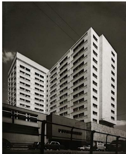
Abb.121 Stirnseite des Längstraktes aus der Sicht der tiefer liegenden Nebenfahrbahn am Heumarkt um 1964
