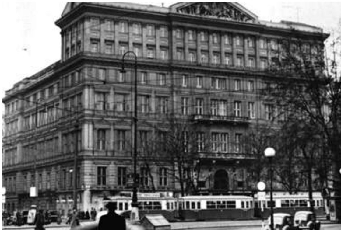
Abb. 52 Wien, Hotel Imperial, 1863-1865 als Palais erbaut, 1873 zu Hotel umgenutzt
