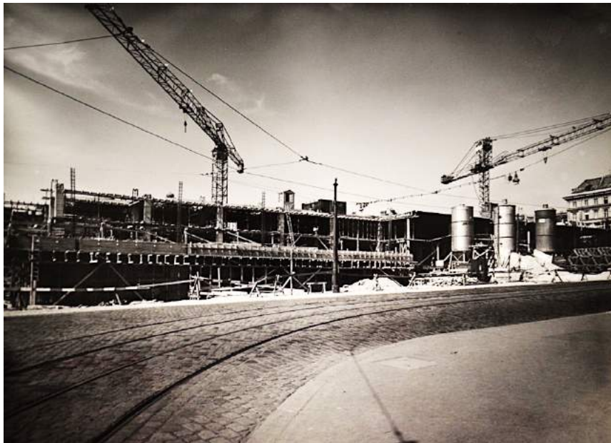
Abb. 193 Bauarbeiten, Abbildung von Architekturfotografin Luca Chmel, auf Fotorücken mit 19. Mai 1962 datiert, Vienna InterContinental
