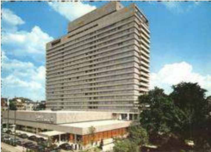
Abb. 28 Frankfurt am Main (Deutschland), InterContinental Frankfurt a. M., Otto Appel, Georg Beckert, 1963
