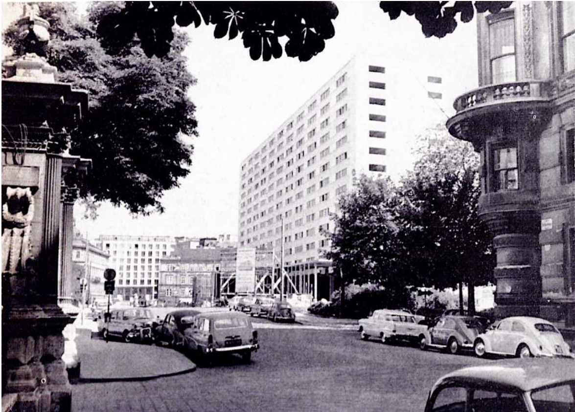
Abb.119 Blick von Johannesgasse zum Hotelneubau, während der Bauphase
