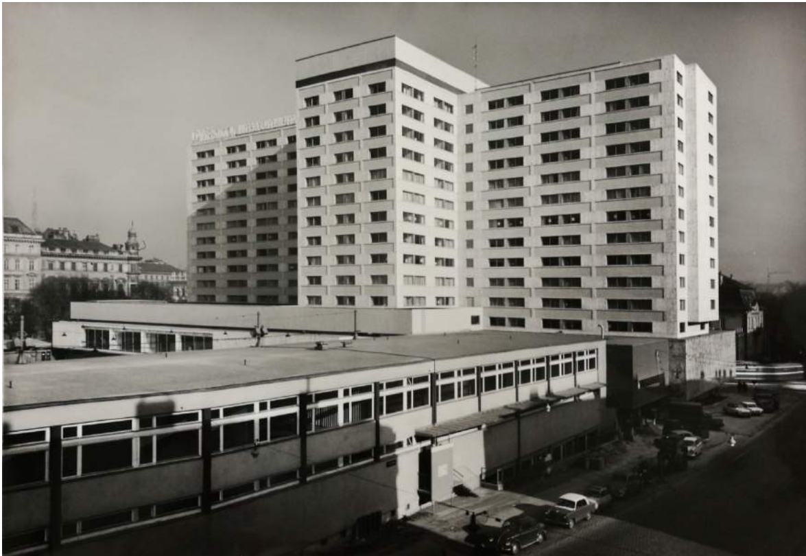
Abb.113 Sicht vom Heumarkt auf Eislaufverein und Rückseite des Hotelgebäudes, 1964
