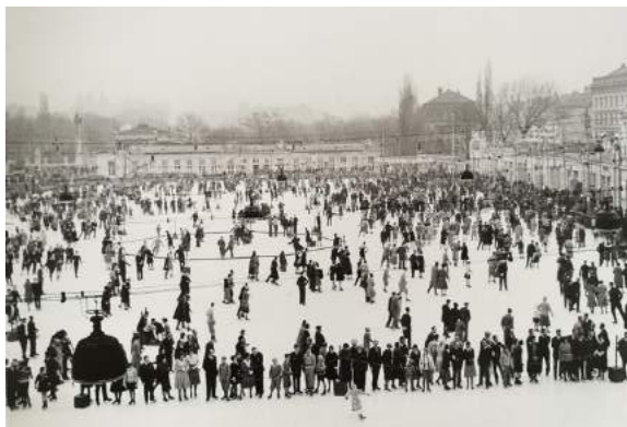
Abb.79 Blick auf die Eislaufflächen der 1959 abgerissenen WEV Anlage
