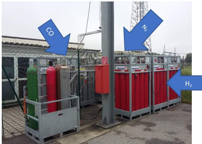
Abbildung 5.13: Versorgung mir Flaschenbündeln aus dem Gaslager
