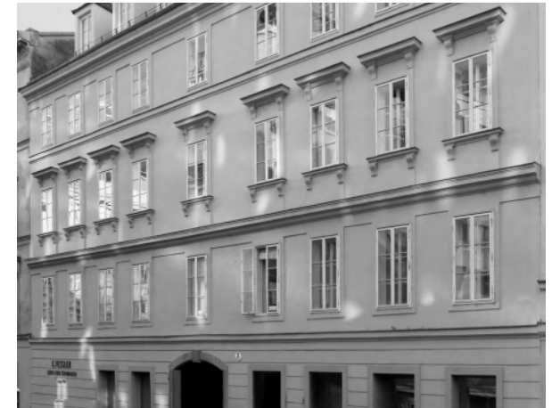
Abb.:3 Frühgründerzeitliches Gebäude mit nach außen öffnenden Fenstern in Pfostenstock-Ausführung; Sechsscheiben Teilung der Fenster; Markante Reflexion der fassadenbündigen Fenster. Mozartgasse 3, 1040 Wien, Architekt unbekannt
