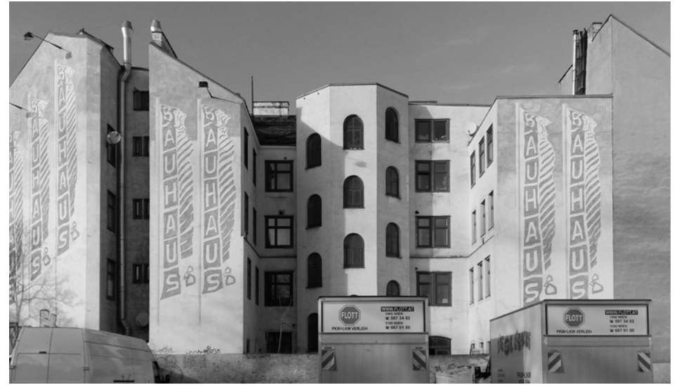
Abb.:54 Ansicht Hof
