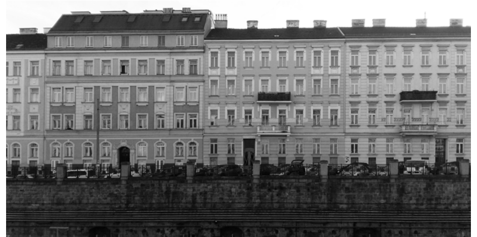
Abb.:63 Gegenüberliegende Fassaden
