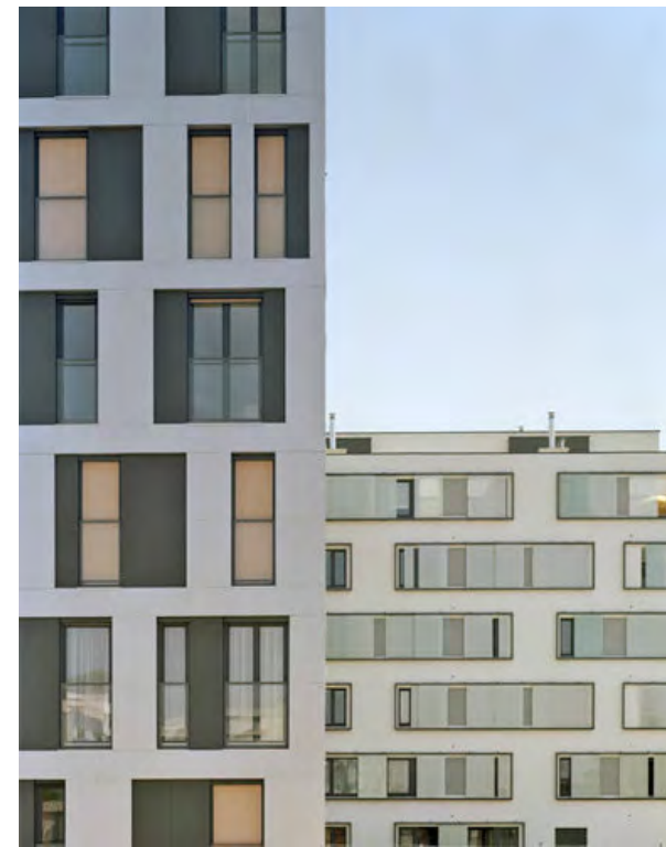
Abb.:33 Wohnbau Attemsgasse, Arge Elsa Prochaska und Baumschlager Eberle PARC ZT
