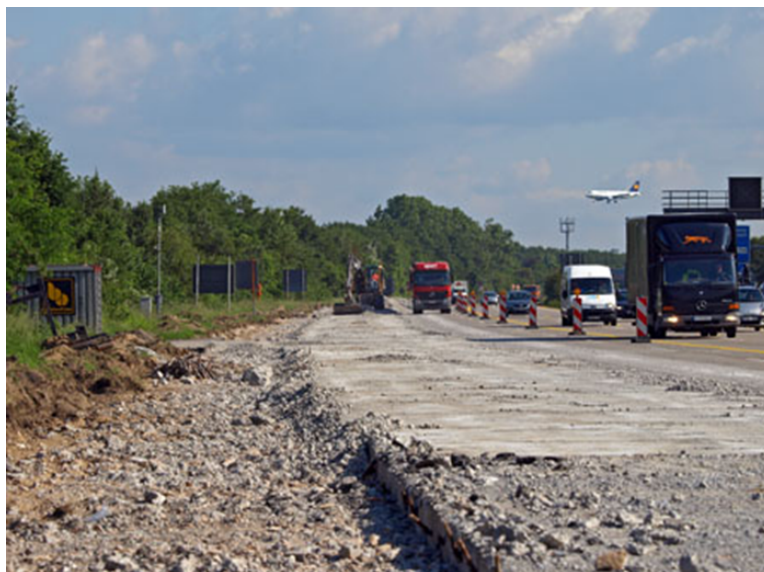
Abbildung 26: Abbruch von Betonfahrbahndecke 117
