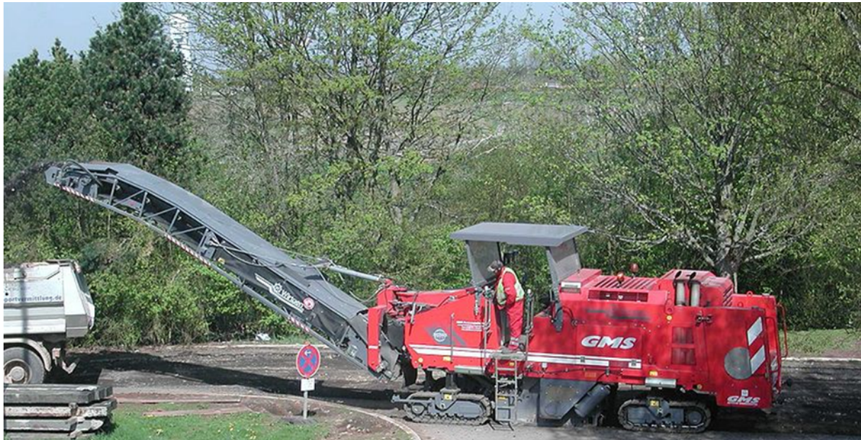
Abbildung 20: Kaltfräse beim Abfräsen einer Asphaltstraße 104
