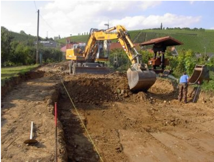
Abbildung 30: Bodenaushub beim Straßenbau 131
