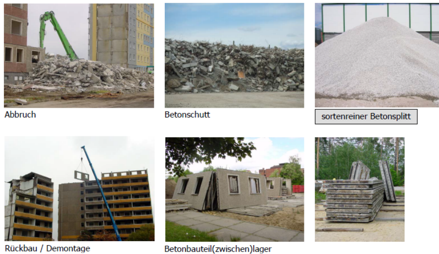
Abbildung 25: Gewinnung Betonabbruch 116
