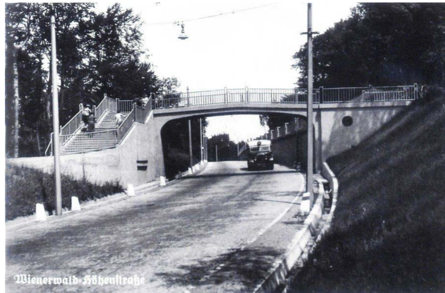
Abb.41: Einzige bestehende Fußgängerüberquerung mittels Brücke
