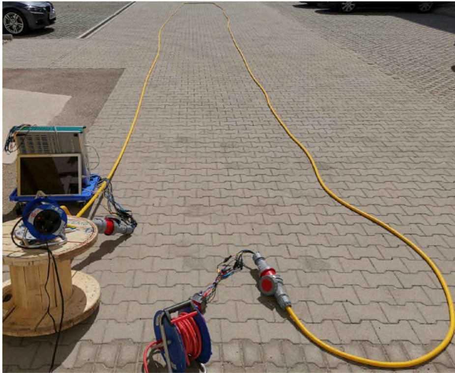
Abbildung 42: Kabel mit 5 \times 16 \text{ mm}^2 ausgerollt am Parkplatz
