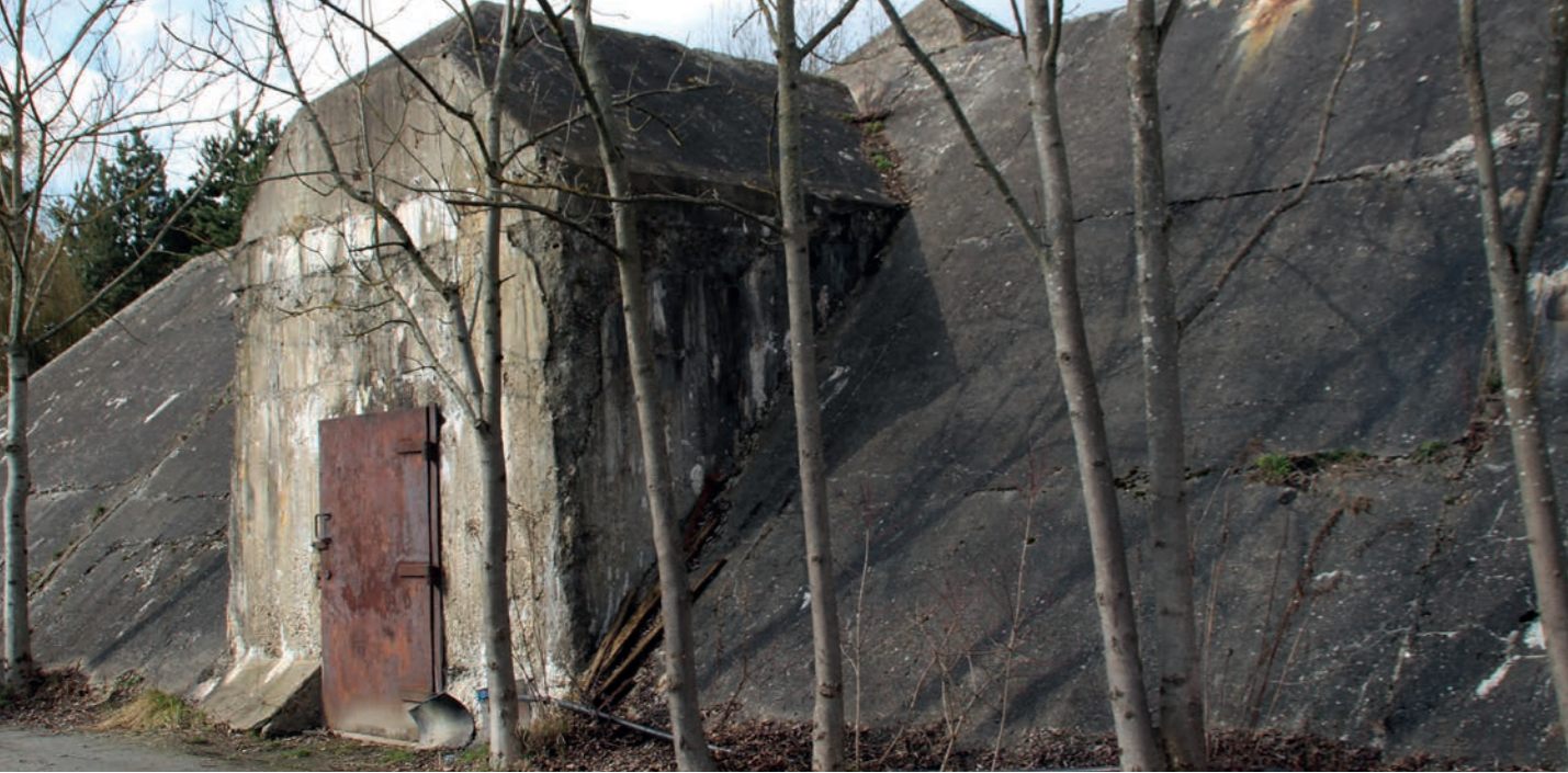
Abb. 56 teilweise freiliegende Bunkeranlagen aus dem II. Weltkrieg
