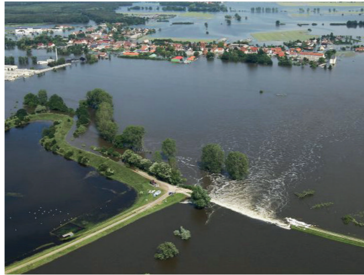
Abb. 09 Deichbruch durch Hochwasser | Fischbeck DE
