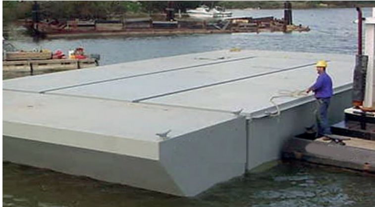
Abb. 81 Zusammenbau mehrerer Stahlbetonpontons
