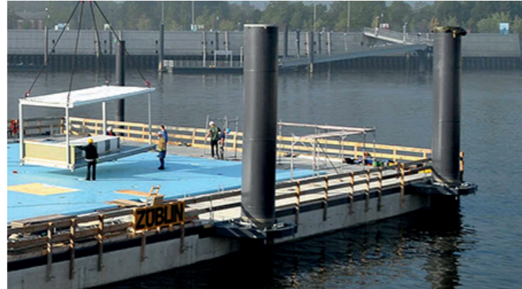
Abb. 82 Fixierung mit Stahlpylonen
