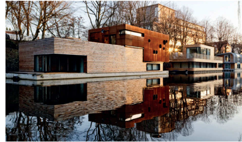
Abb. 17 | 18 moderne schwimmende Häuser am Eilbekkanal | Hamburg DE
