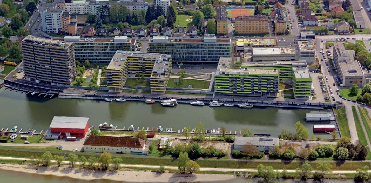
Abb. 60 Wohnsiedlung in erster Reihe am Südufer des Winterhafens
