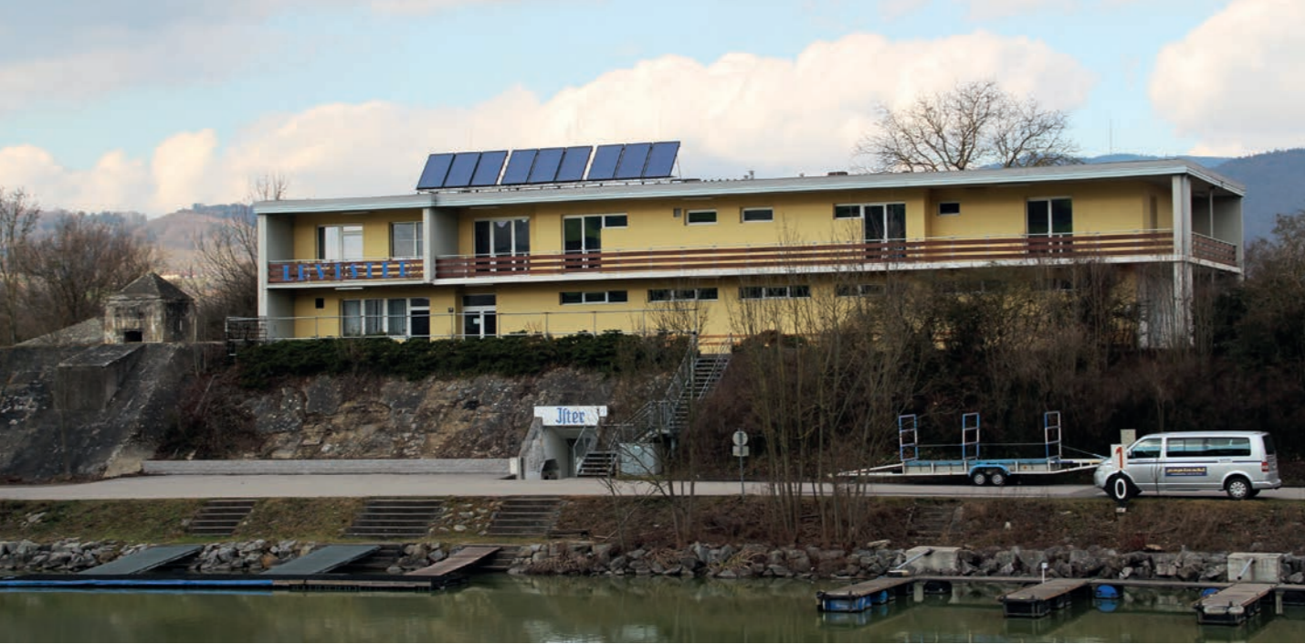
Abb. 58 Clubhaus des Rudervereins Ister auf dem westlichen Luftschutzbunker
