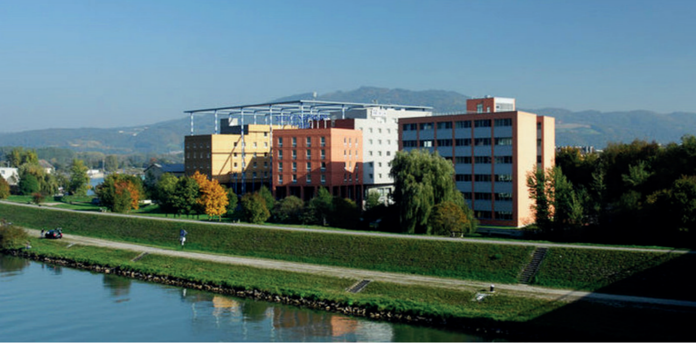
Abb. 62 Hotel am Westufer des Winterhafens
