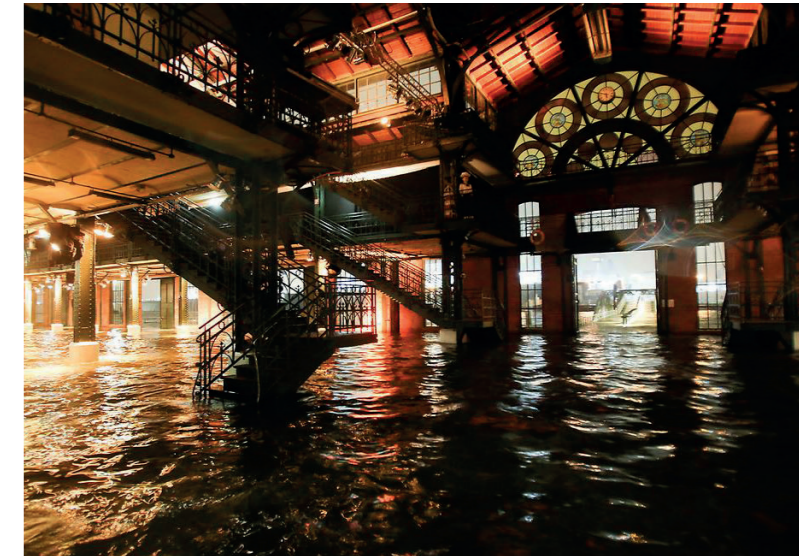
Abb. 06 Überflutung der Fischauktionshalle | Hamburg DE
