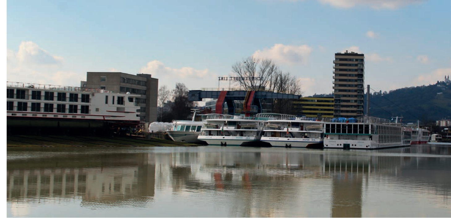
Abb. 59 Slipanlage und Brücke der Schiffswerft am Südufer des Winterhafens
