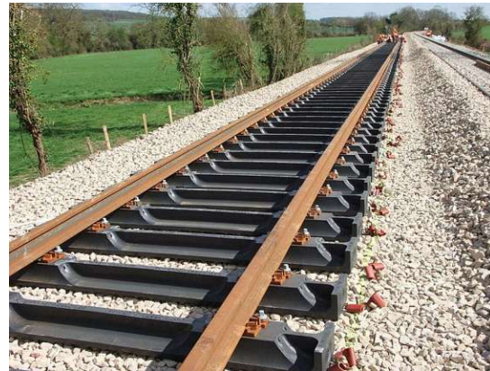
(d) Recycled plastic sleepers
