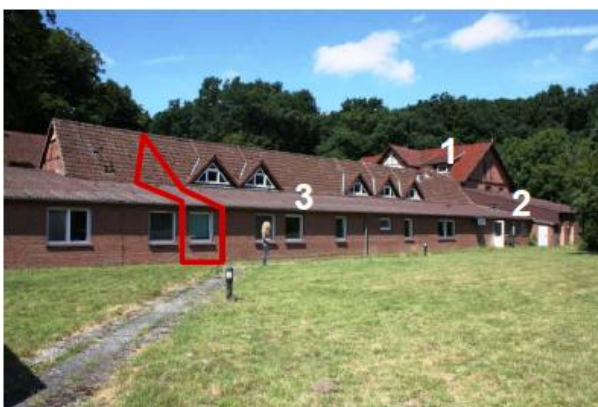
Abb. 36: Ost-Ansicht des langgezogenen Pflge- traktes (zukünftiger „Pflgeoasen“)
