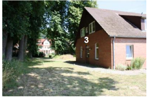
Abb. 33: Sicht von Süden auf den langgezogenen Pflge- trakt / Westgiebel
