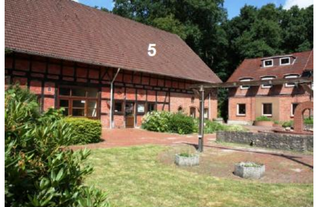
Abb. 27: Blick vom Innenhof auf die Fassade der Scheune
