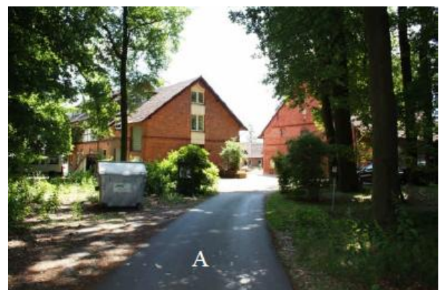
Abb. 37: Aktuelle Hauptzufahrt zu den Bestandsgebäuden
