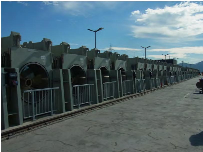
Abbildung 1: Absenkbare Turbinenmodule entlang eines Staudamms<sup>[2]</sup>
