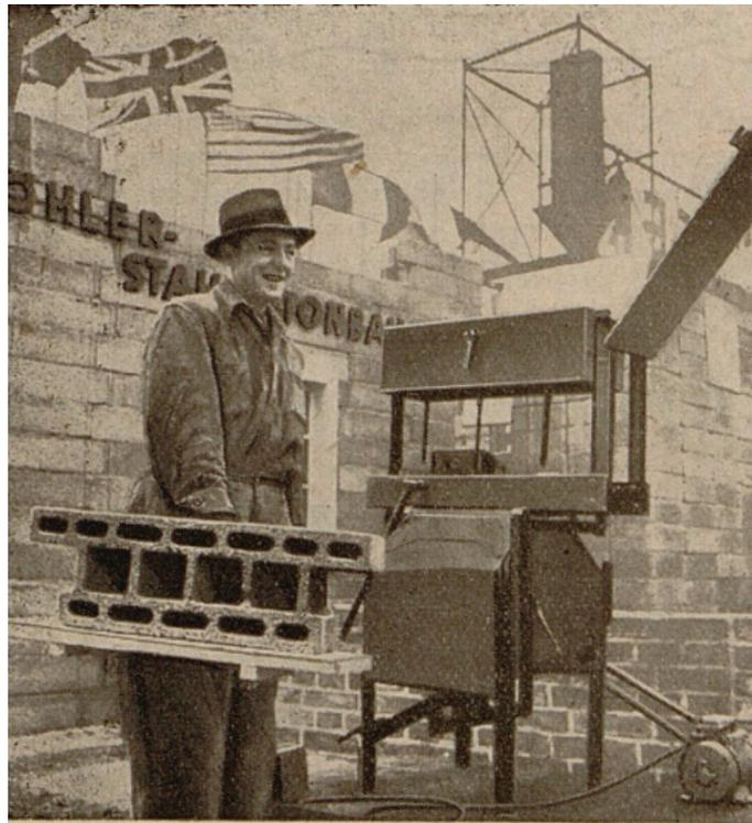
Abb. 15: Böhler-Riesenziegel mit Vibrospezialmaschine
