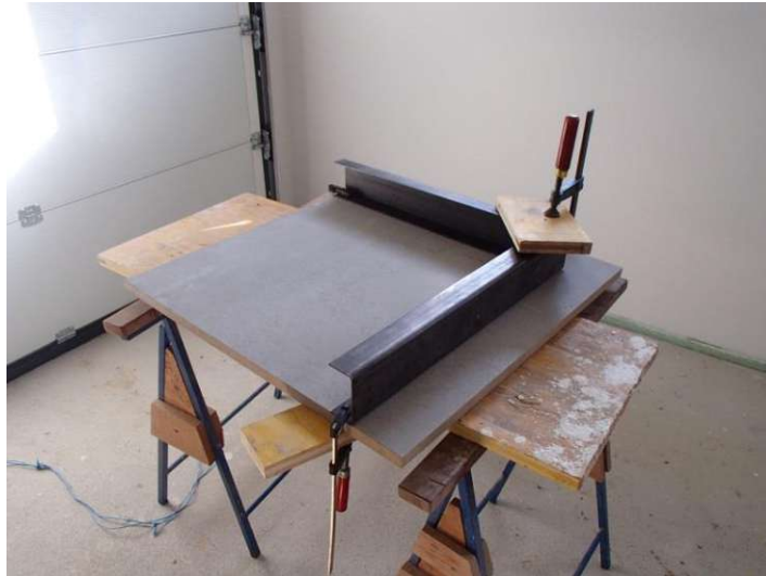
Abb 67: Platte mit Unterkonstruktion der 1.Dämmebene
