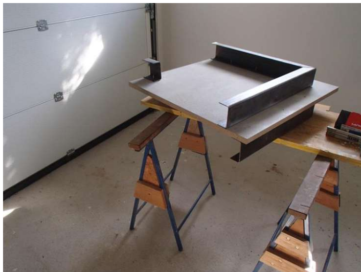
Abb 68: Platte mit Unterkonstruktion der 1.+2.Dämmebene
