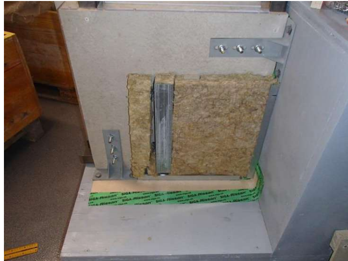
Abb 81: Verlegung Dämmung Vorsatzschale
