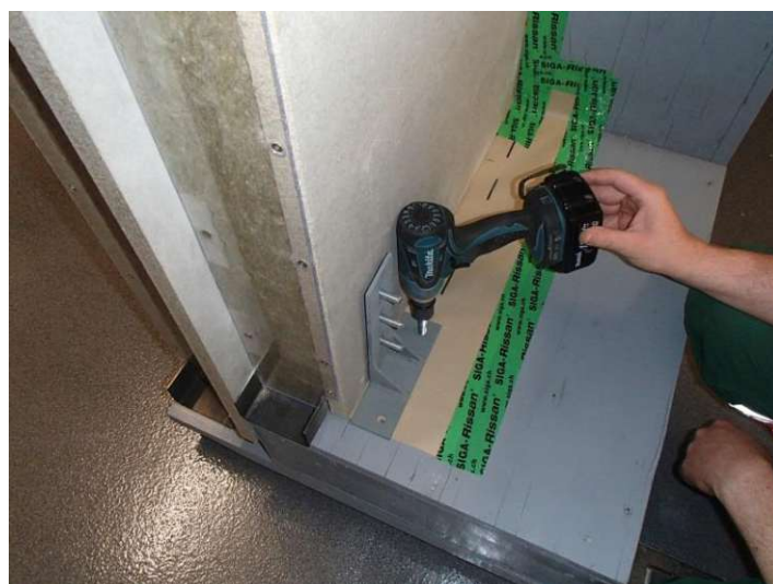
Abb 78: Verschraubung Befestigungswinkel
