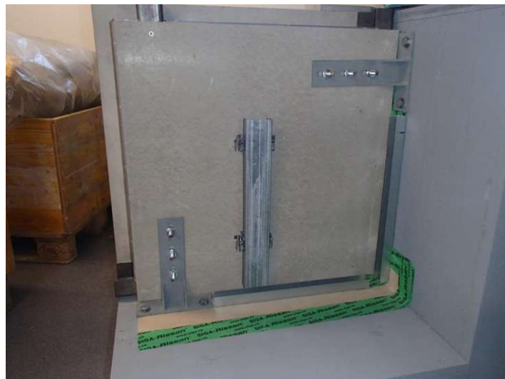
Abb 80: Unterkonstruktion Vorsatzschale
