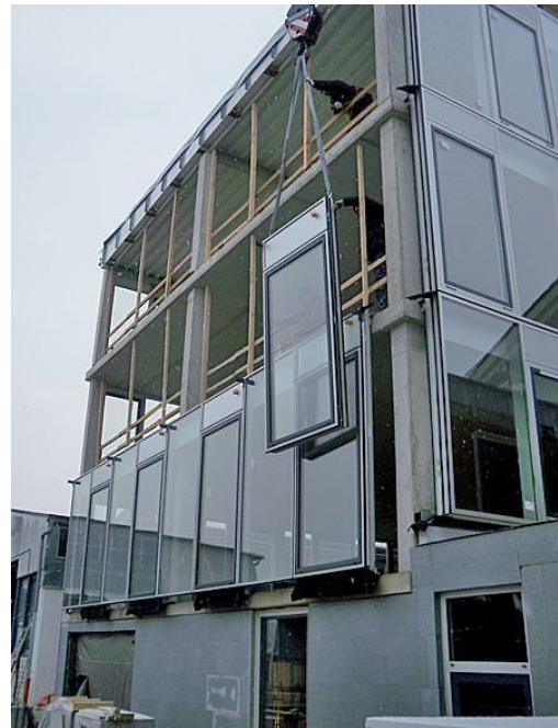
Abb 7: Pfosten-Riegel Fassade und Elementfassade
