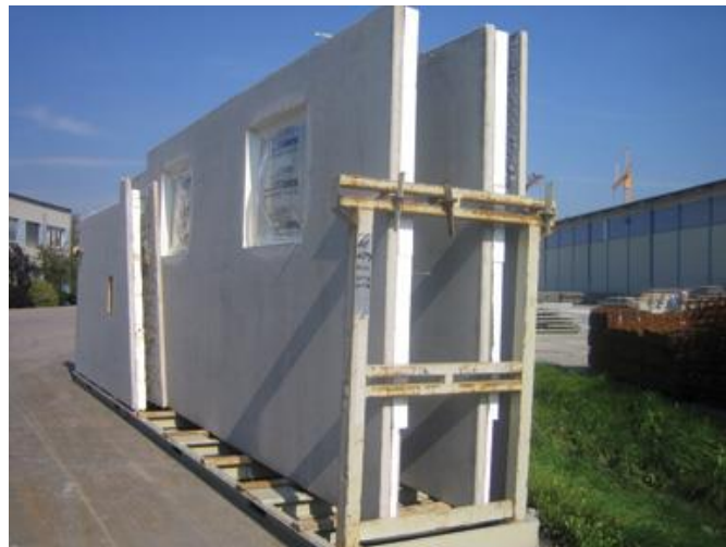
Abb 63: Transportgestell vor der Aufnahme des Sattelauflegers [37]
