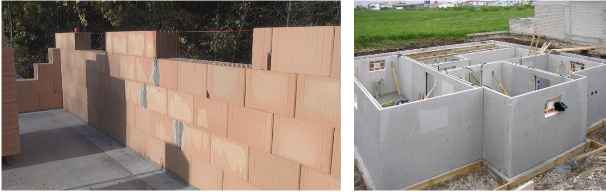
Abb 1: Ziegelwand und Stahlbetonwand
