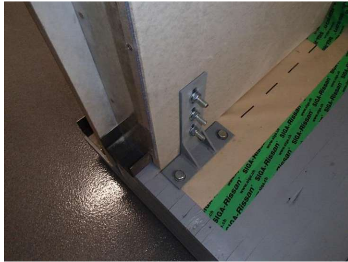
Abb 79: Verschraubung Platte/Winkel
