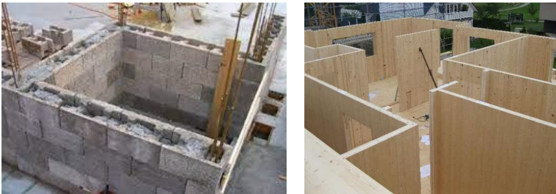
Abb 2: Holzspan-Verfüllsteine und Brettsper Holzwand
