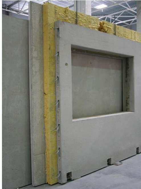
Abb 8: Stahlbeton-Sandwichwandkonstruktion mit MW Dämmung
