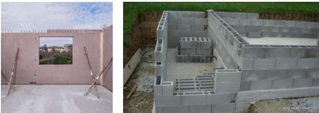
Abb 3: Ziegelsplittbetonwand und Betonverfüllsteinwand
