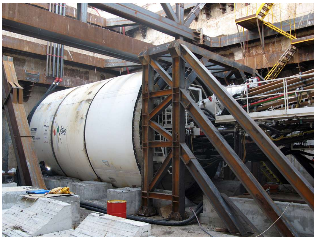
Abb. 3.6: Anfahrvorgang mittels Rücksteifkonstruktion (Quelle: [76] TunnelPro S.r.l.)
