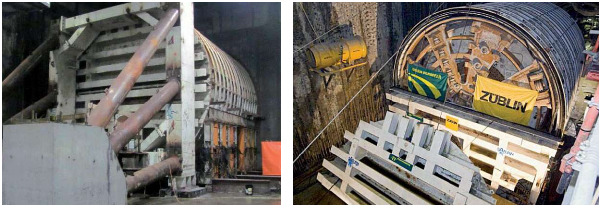
Abb. 3.26: Zielkonstruktion des STS (Quelle: [28] Friedemann et al.)
