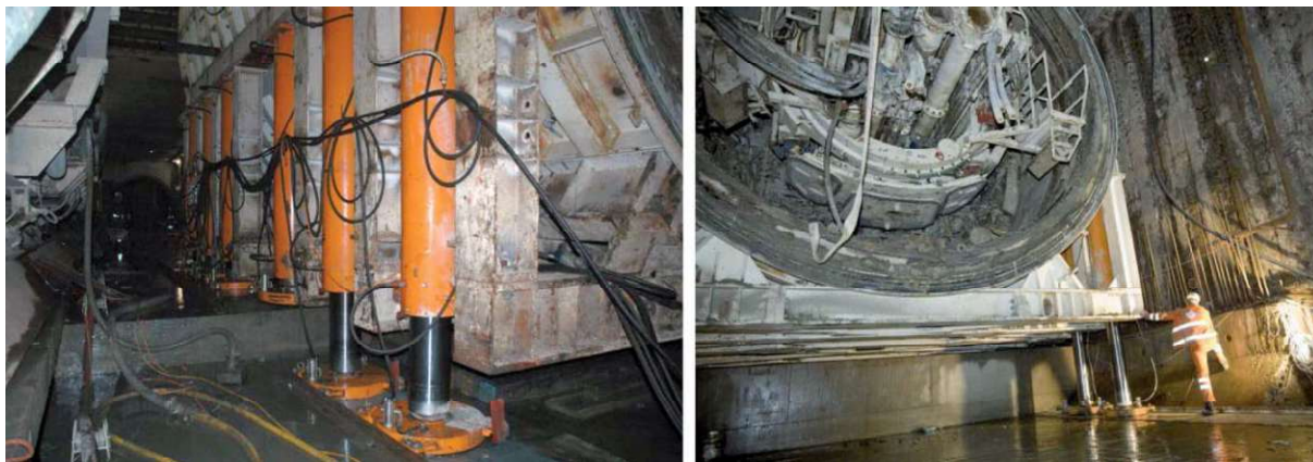
Abb. 3.18: Hub des STS über eine Stufe (Quelle: [28] Friedemann et al.)
