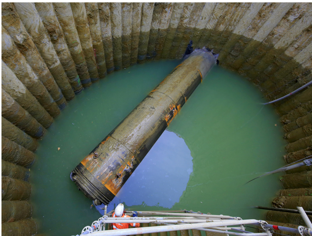
Abb. 3.27: Wassergefluteter Zielschacht (Quelle: [50] Oberhäuser)
