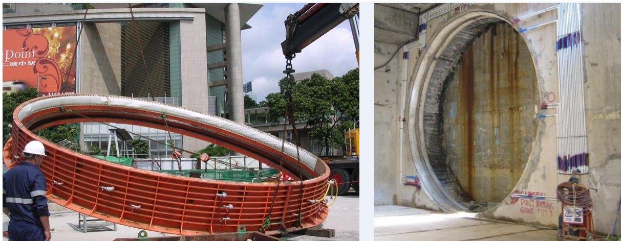
Abb. 3.11: Einbau der Schlauchdichtung in der Startbrille (Quelle: [7] BuM Beton- und Monierbau GmbH und [6] BuM Beton- und Monierbau GmbH)
