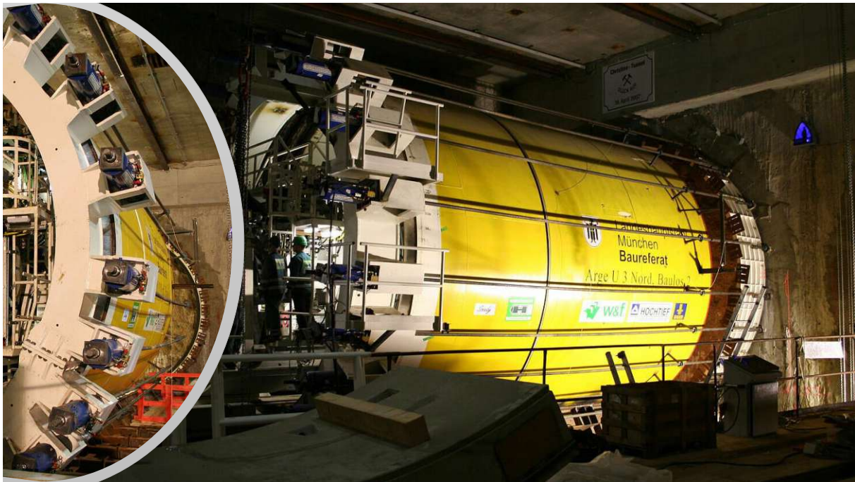
Abb. 3.14: Fliegende Schildanfahrt (Quelle: [64] Schütz und [63] Schütz)
