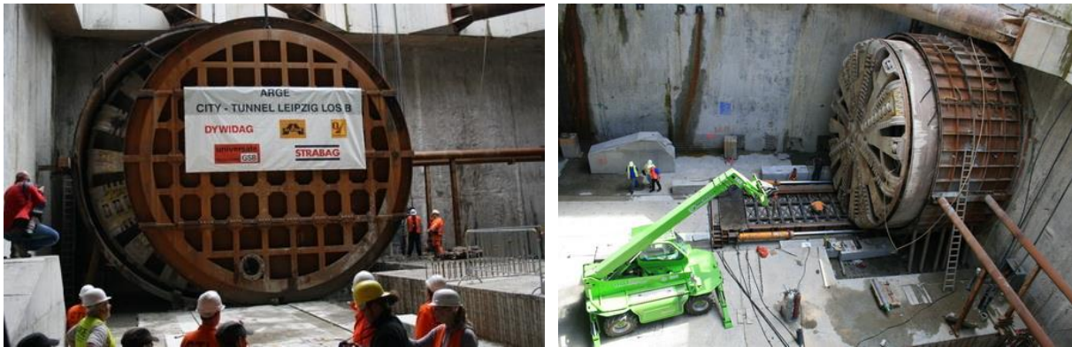
Abb. 3.23: Dichttopf des City-Tunnel Leipzig (Quelle: [20] Erritt und [19] Erritt)
