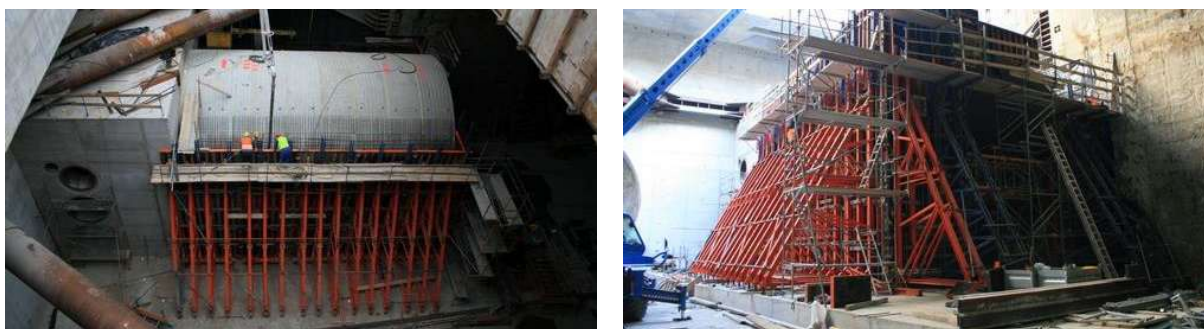
Abb. 3.15: Betontopf des City-Tunnel Leipzig (Quelle: [18] Erritt und [21] Erritt)
