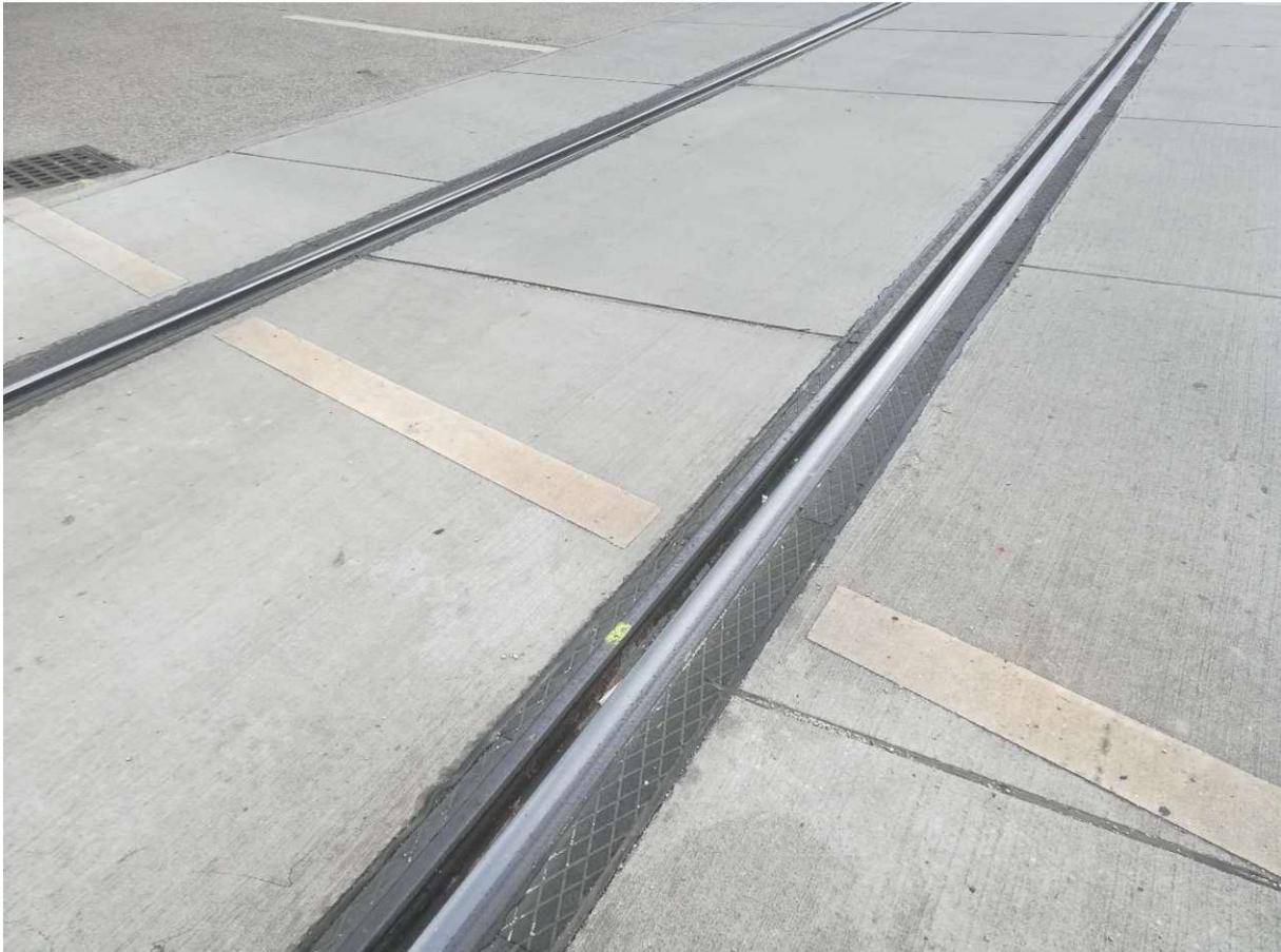
**Abb. 14:** Gleis mit Eindeckung aus Ortbeton im Wiener Straßenbahnnetz (Mariahilfer Gürtel). Quelle: eigene Aufnahme
