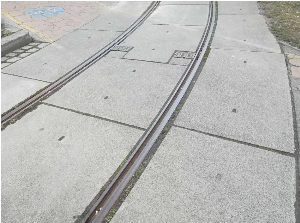
Abb. 13: Gleis mit Eindeckung aus Fertigteilplatten aus Beton im Wiener Straßenbahnnetz (Mariahilfer Gürtel). Quelle: eigene Aufnahme
