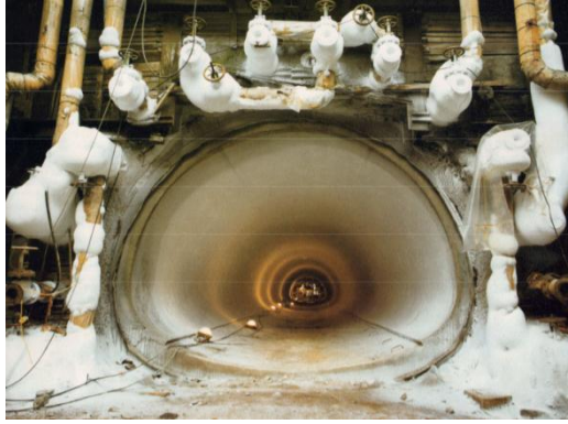
Abbildung 47: Beispiel einer Bodenvereisung im Tunnelbau [28]
