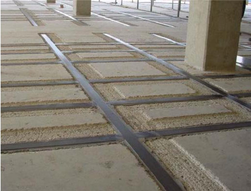
Abbildung 52: Verstärkung der Biegelängsbewehrung im Durchstanzbereich [48]
