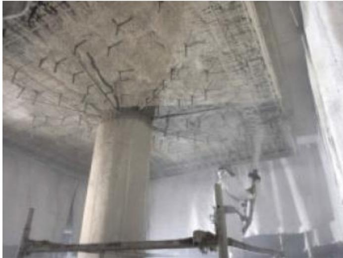
Abbildung 53: Spritzbeton als Verstärkung des durchstanzgefährdeten Bereich einer Flachdecke, aus [47]
