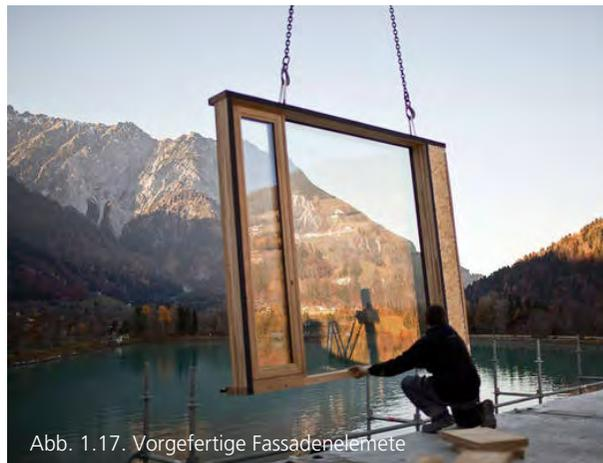
Abb. 1.17. Vorgefertigte Fassadenelemente
