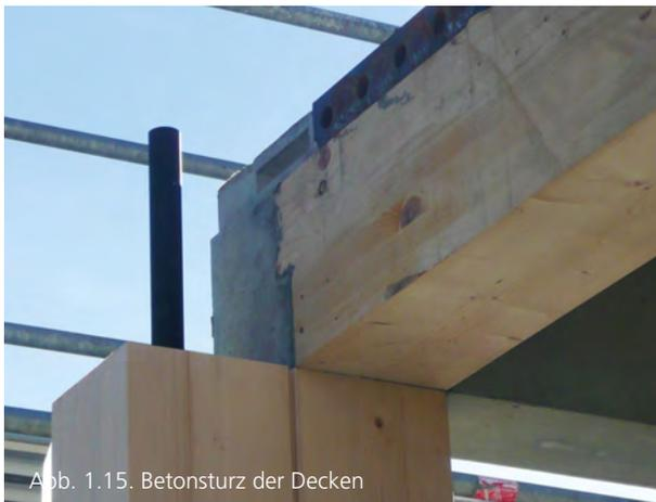
Abb. 1.15. Betonsturz der Decken
