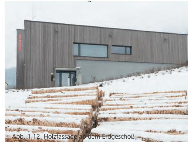
Abb. 1.12. Holzfassade ab dem Erdgeschoß
