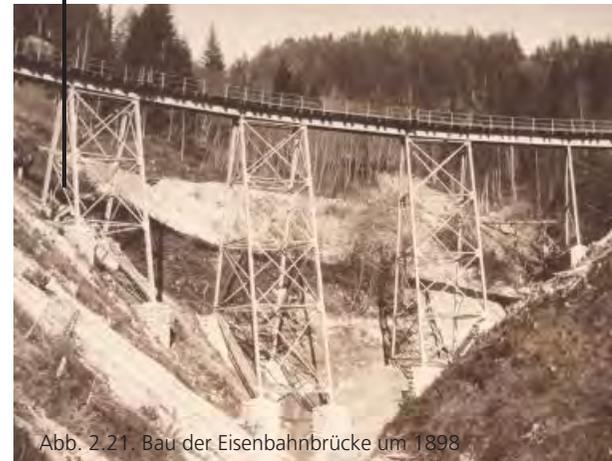
Abb. 2.21. Bau der Eisenbahnbrücke um 1898
