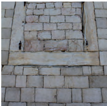
Abb.96 Dachräume zwischen der Lager Abb.97 Dachstuhl, Lager V Abb.98 Dach, Detail Abb.99 Dach, Detail Abb.100 Dach Abb.101 Zugemauerte Fenster Öffnung
