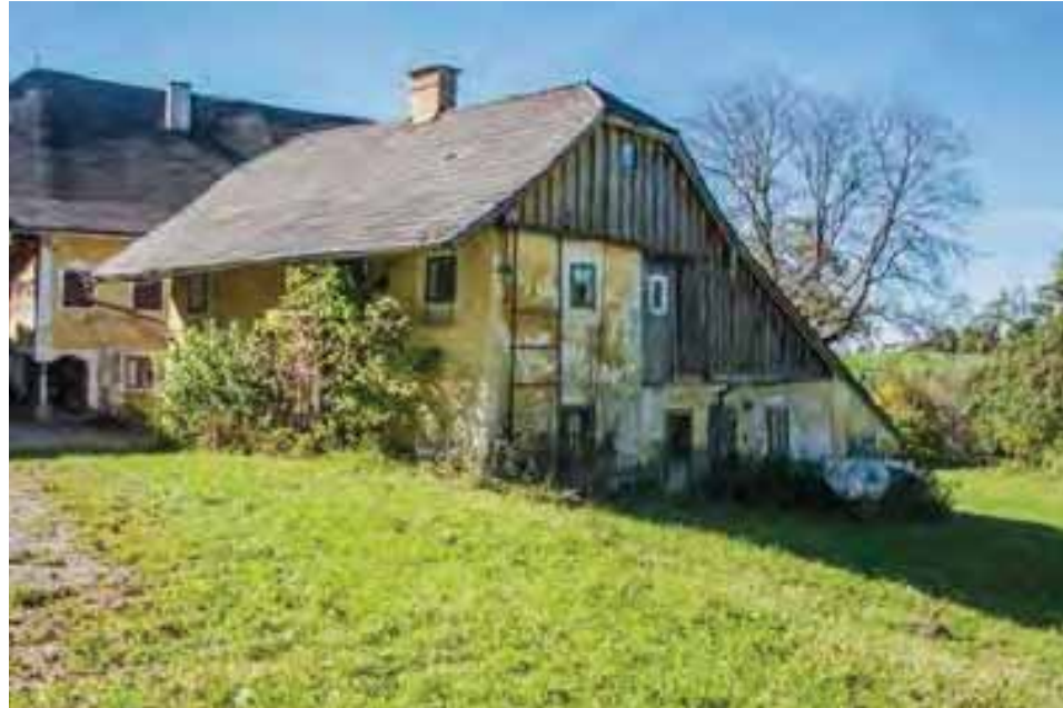
Abb. 26 : Seitenfassaden, Moarhäusel, Gut Guggenthal
