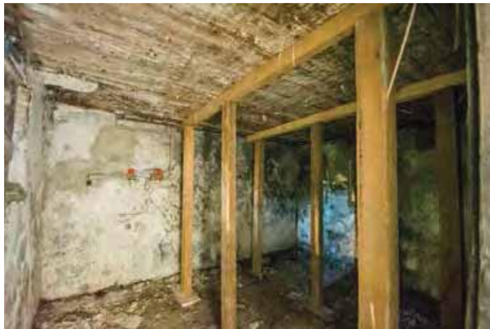
Abb. 31 : Tragwerksunterstützung im Erdgeschoss, Schmiedhäusel, Gut Guggenthal
