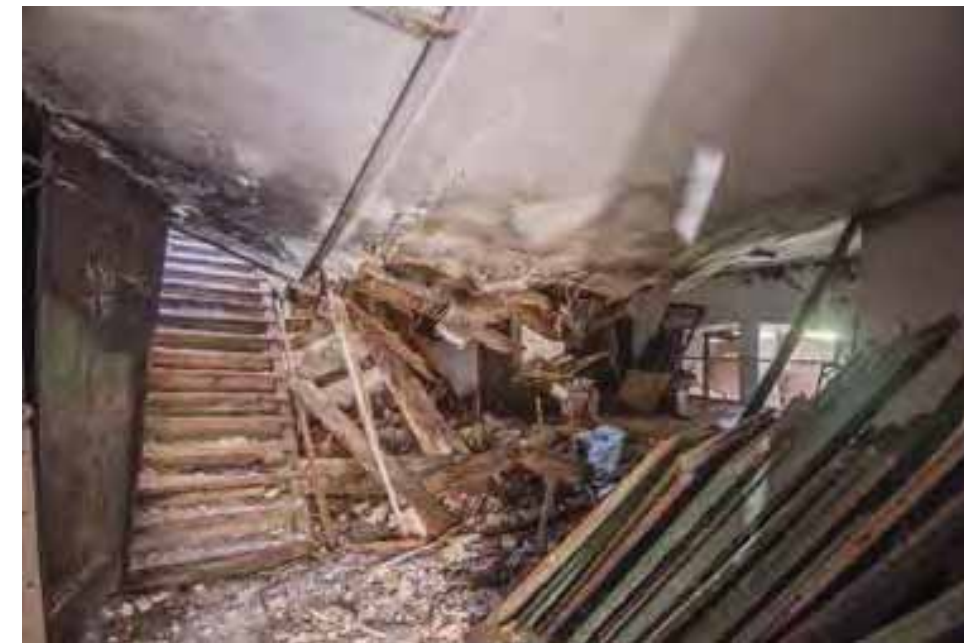
Abb. 45 : Deckendurchbruch im Mittelrisalit, Obergeschosse, Brauerei, Gut Guggenthal
