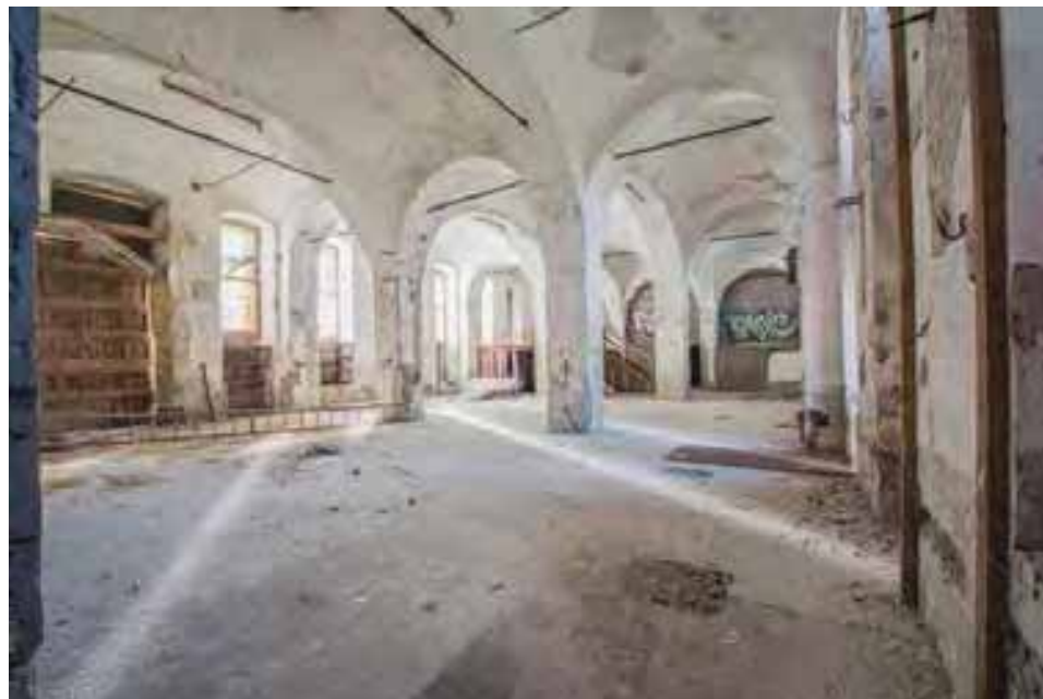
Abb. 47 : Sudhalle, Obergeschoss, Brauerei, Gut Guggenthal
