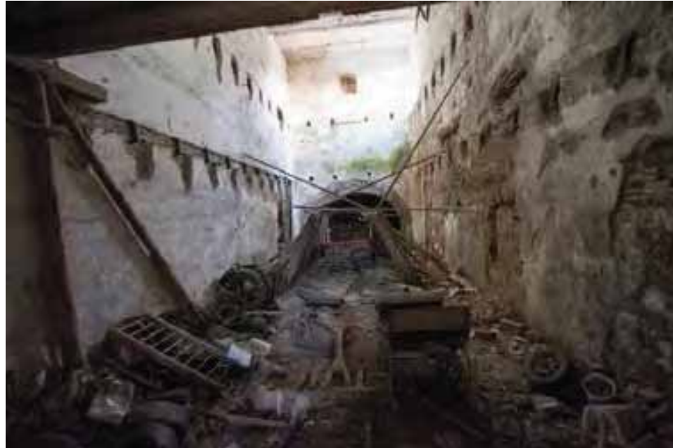
Abb. 46 : Westlicher Lagerraum, Erdgeschoss, Brauerei, Gut Guggenthal
