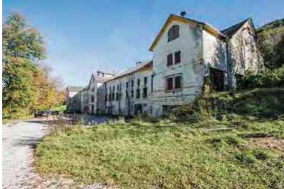
Abb. 42 : Frontfassade, Brauerei, Gut Guggenthal
