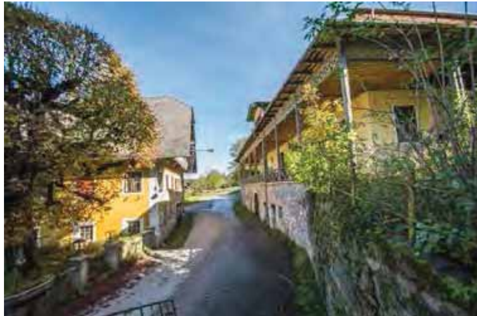
Abb. 21 : Alte Grazer Bundesstraße zwischen Gasthaus und Villa
