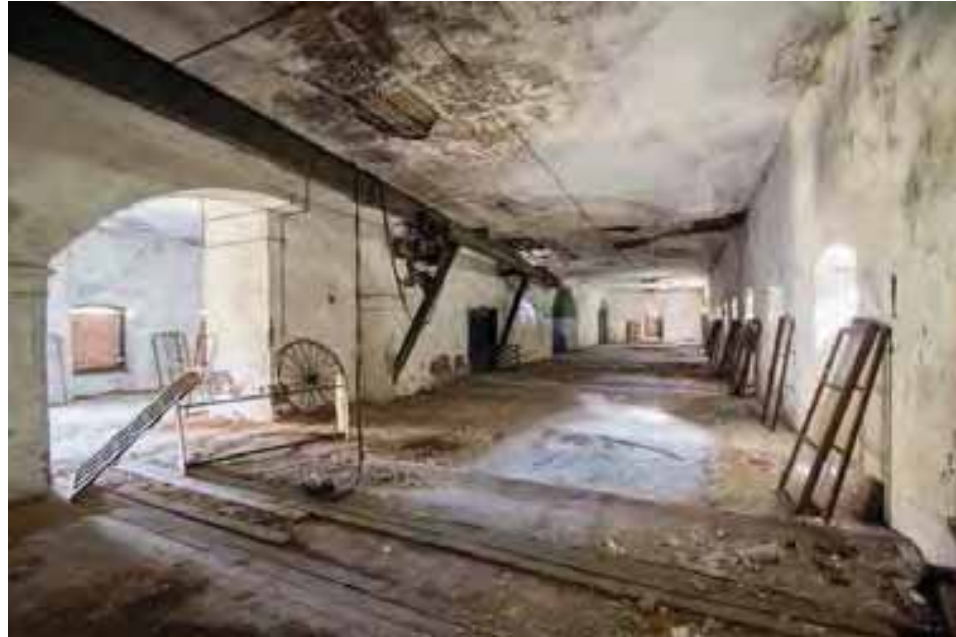
Abb. 48 : Malzboden, 2. Obergeschoss, Brauerei, Gut Guggenthal
