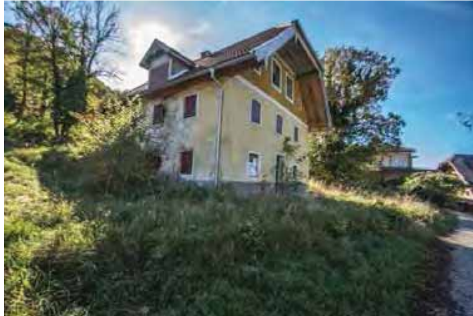
Abb. 28 : Frontfassade, Schmiedhäusel, Gut Guggenthal
