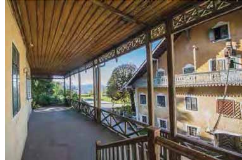
Abb. 37 : Veranda, Erdgeschoss, Villa, Gut Guggenthal
