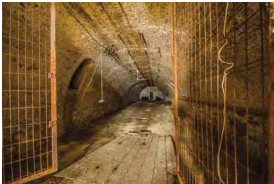
Abb. 41 : Eiskeller, Untergeschoss, Villa, Gut Guggenthal
