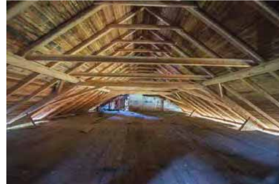
Abb. 44 : Renovierter Teil des Dachstuhls, Brauerei, Gut Guggenthal
