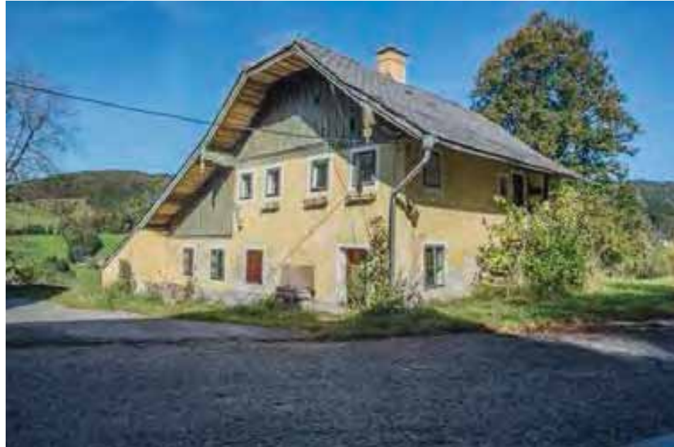
Abb. 24 : Frontfassade Moarhäusel, Gut Guggenthal
