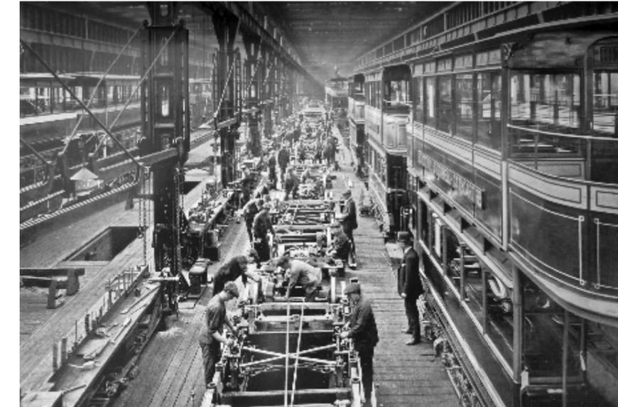
Abb. 160: In dieser Werkstatt wurde das Fahrwerk der Straßenbahnen zusammengestellt.
