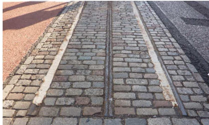
Abb. 16: Überreste der Straßenbahnschienen in Waterloo Place. Sie stammen noch aus der Zeit der Kabelstraßenbahnen, erkennbar an der dritten mittleren Schiene für das Kabel.
