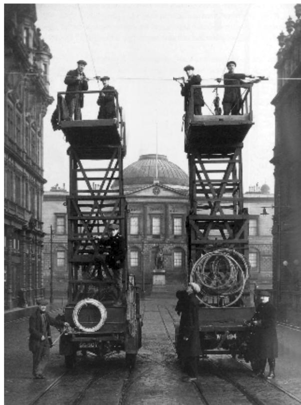
Abb. 8: Die Elektrifizierung der Kabelstraßenbahn
