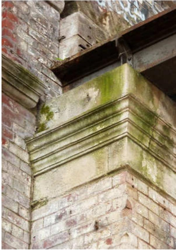
Abb. 259: Stein-Ziegel-Verbindung
