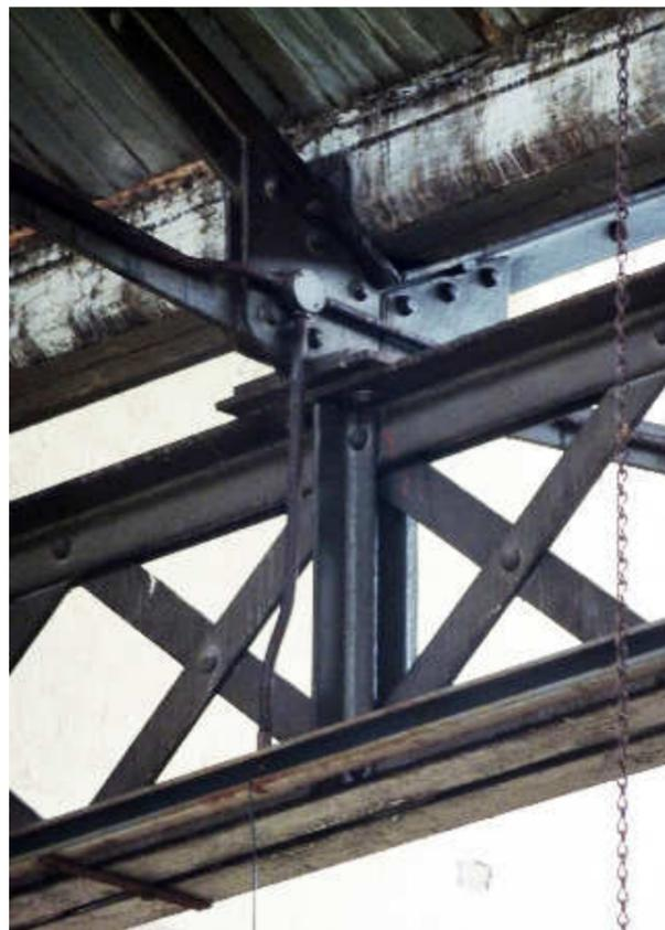
Abb. 264: Beispiel für verschraubte Eisenelemente
