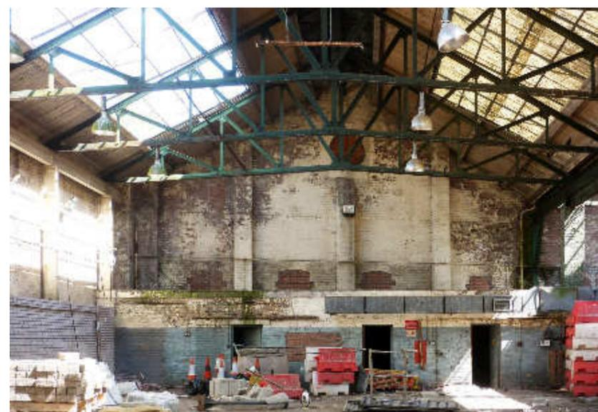
Abb. 133: Die hintere Giebelwand mit den feuersicheren Fluchtgängen und Sanitärräumen, die heute nicht mehr genutzt werden.
