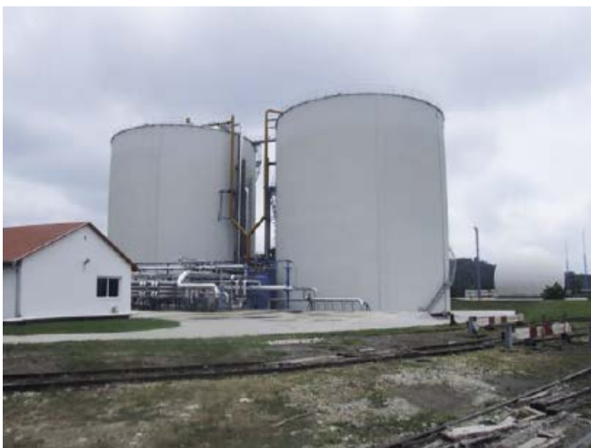
Abb. 3: Die Anaerobanlage der Zuckerfabrik Kaposvár im Jahre 2007
