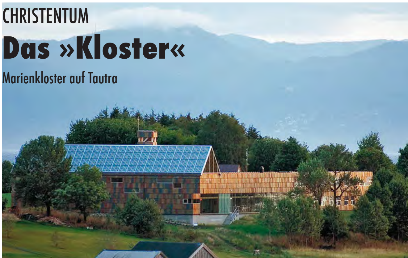
ABB. 1 Blick von außen
