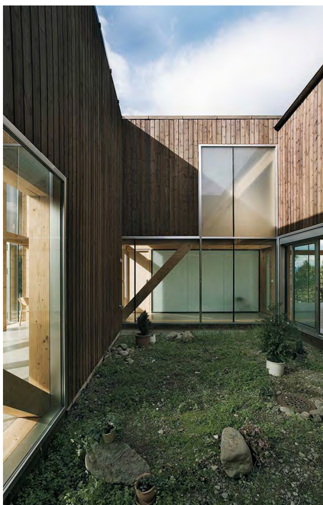
ABB. 2 Blick in den Innenhof
