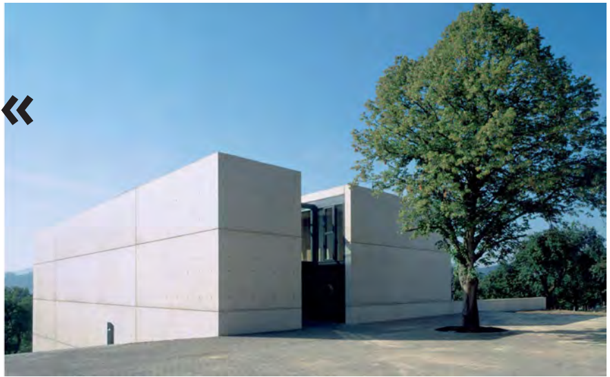
ABB. 4 Blick von außen
