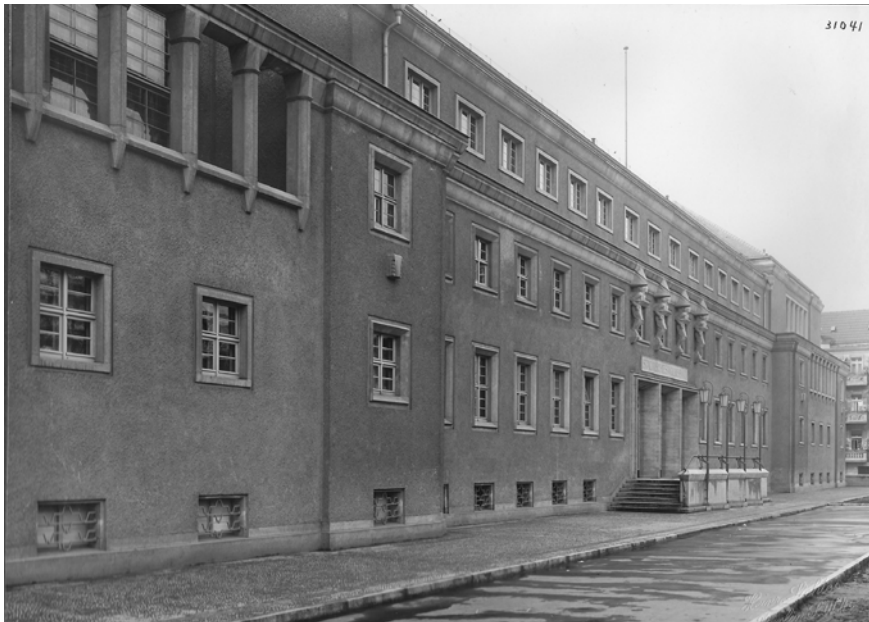
ABB. 2 Fassade- denansicht der Nordseite. Das Hu- bertusbad befindet sich in der Atzpo- dienstraße 6-8 und der Hubertusstraße 47-49, D-10365 Ber- lin. Es ist ca. 4.200 m 2 groß.
