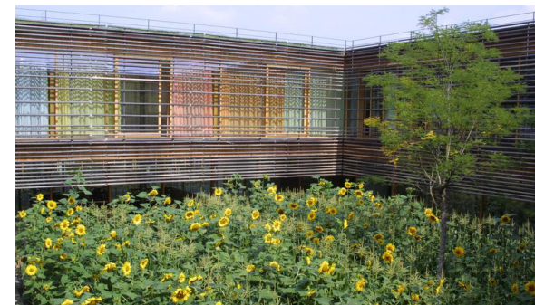
Abb. 07: REHAB Basel Innenhof
