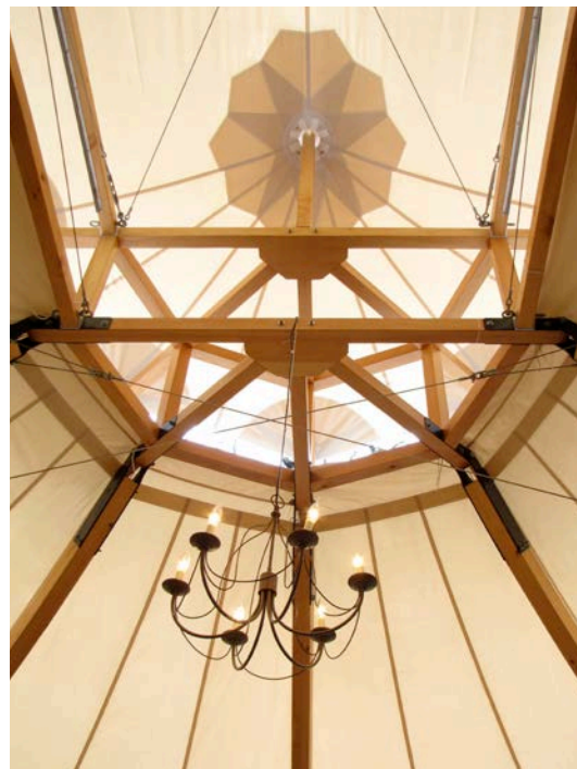
Abb.21. Sperry Fabric Architecture; Ansicht von innen
