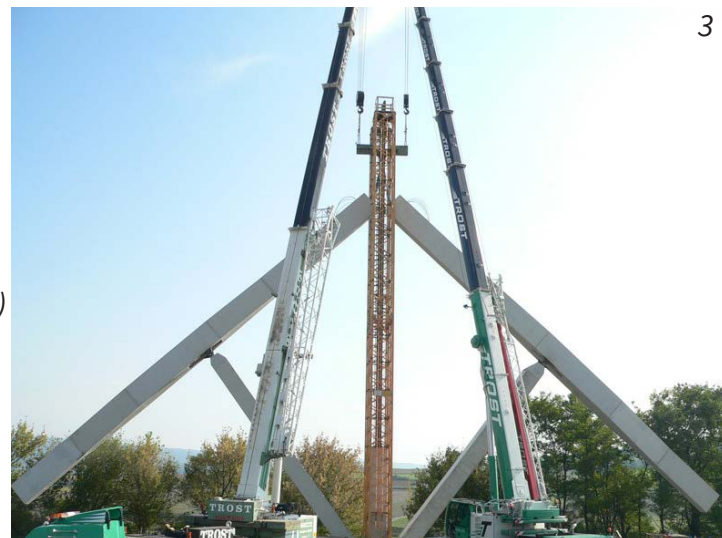
Abb.33. Institut für Tragkonstruktionen; Ablauf des Brückenklappverfahrens
