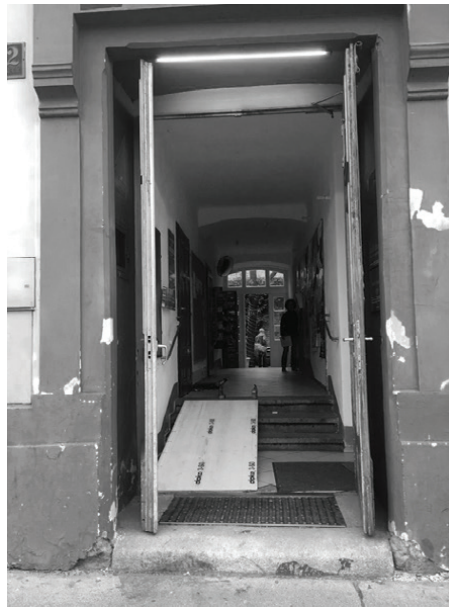
2. Selbst gebaute Rampe 2017 (TRLV) . Detail
