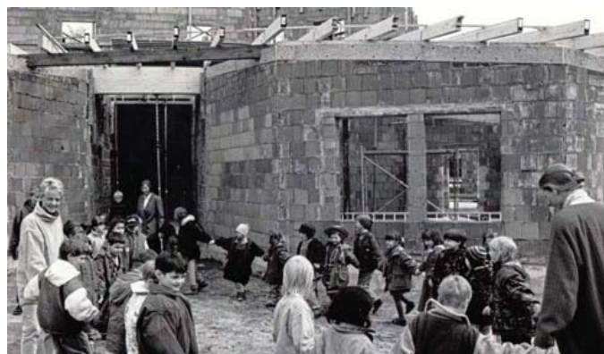
Abb. 1.9.: Waldorf-Kindergarten, Ladenkamp in Rohbau, 1994
