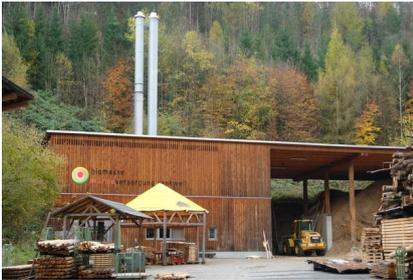
Wald-Hackschnitzel-Kraftwerk, Leistung 1,7 MW, Energie 10.000 MWh th/a, Rankweil, Vorarlberg
