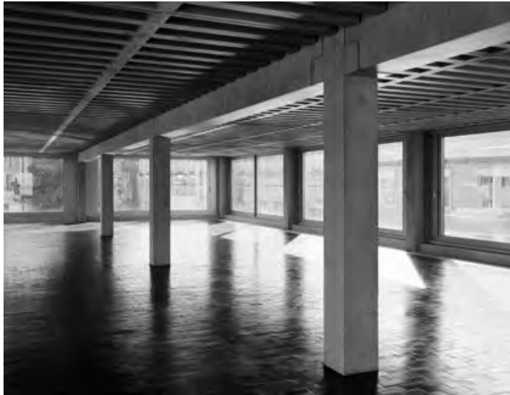
Das durch von Ballmoos Krucker Architekten erbaute EWZ-Werkgebäude in Buchs, stellt seine Struktur aus vorgefertigten Betonelemente frei zur Schau.
