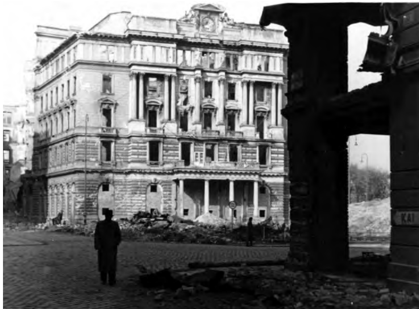
Kriegszerstörungen. Im Vordergrund das ausgebombte Hotel Metropol. Links die Ruinen des Herminenhofes
