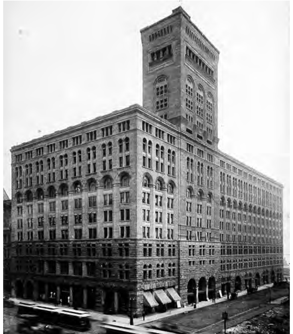
Das 1889 in Chicago errichtete Auditorium Building in Chicago, vereint die moderne Stahlbauweise und die mit ihr einhergehende neue Größenordnung mit einer historistischen Fassadengestaltung
