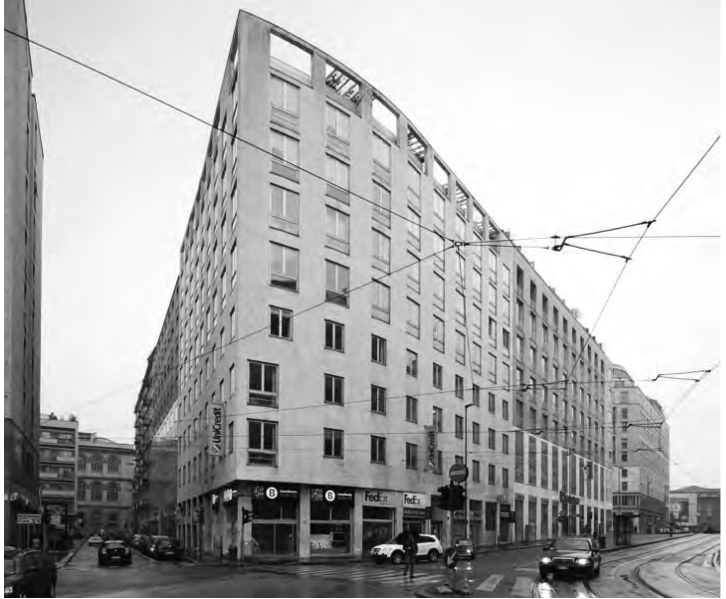
Wohn- und Geschäftshaus an der Via Albricci, Asnago/ Vender, Mailand, 1958
