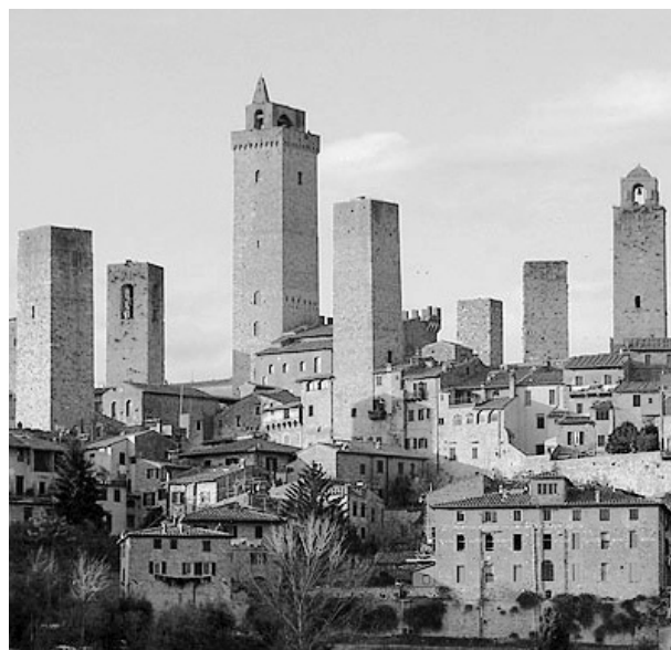
Die Geschlechtertürme von San Gimignano
