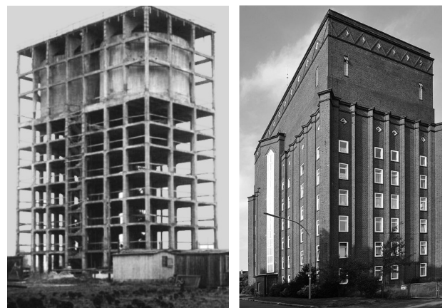
Auf dem linken Bild sieht man den den Wohnwasserturm während der Konstruktion und im rechten Bild den Turm nach seiner Fertigstellung.
