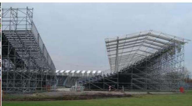
Abb. 132 & 133: Temporäres Fußballstadion mit Gerüsttribünen. Ein Beispiel für die Möglichkeiten mit mobiler Struktur
