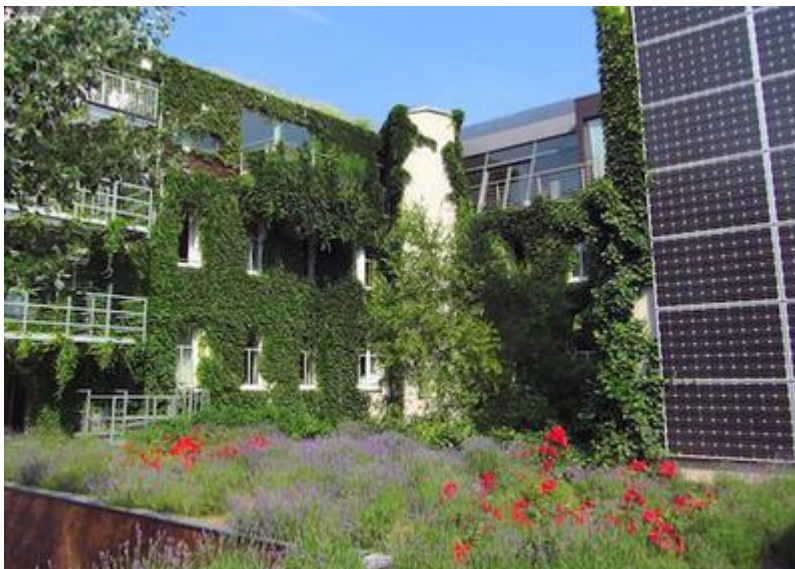
Abbildung 6 Fassaden- und Dachbegrünung samt Solaranlage Boutiquehotel Stadthalle ( www.zerowasteaustria.at/boutiquehotel-stadthalle.html ) - abgefragt am 16.1.2019
