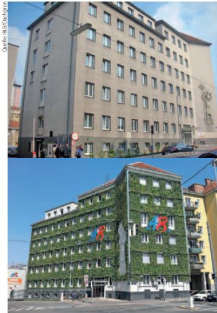
Abbildung 3 Amtsgebäude der MA 48 vor und nach der erfolgten Begrünung im Jahr 2010 (Voraberger 2010, MA48: Pilotprojekt Grüne Fassade auf der Zentrale der MA48 – Vertikalbegrünung als aktiver Beitrag zur Lebensqualität in Wien, http://www.ots.at/presseaussendung/OTS_20100912_OT0003 ) – abgefragt am 10.12.2018)
