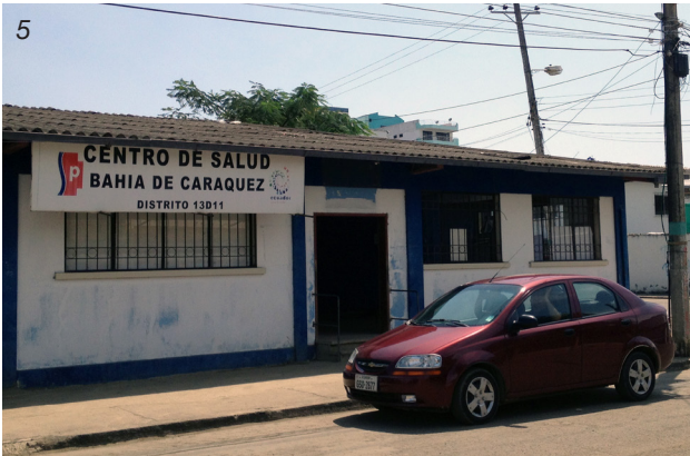
Abb 27 : Gesundheitszentrum in ehemaligem Restaurant als temporäre Nutzung
