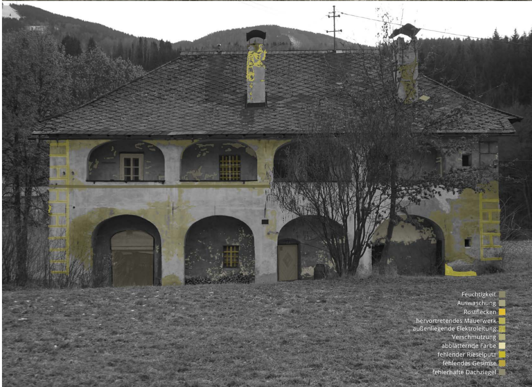
ABB.63: SCHADENSKATASTER NORDFASSADE
