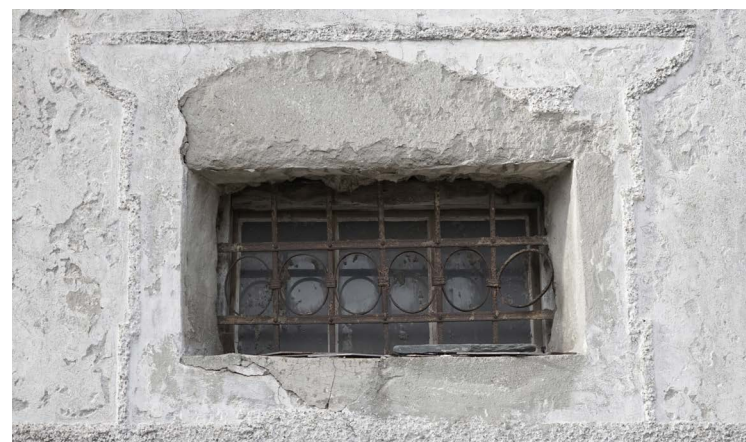
ABB. 61: BAROCKES SCHMIEDEEISENGITTER (OSTFASSADE)
