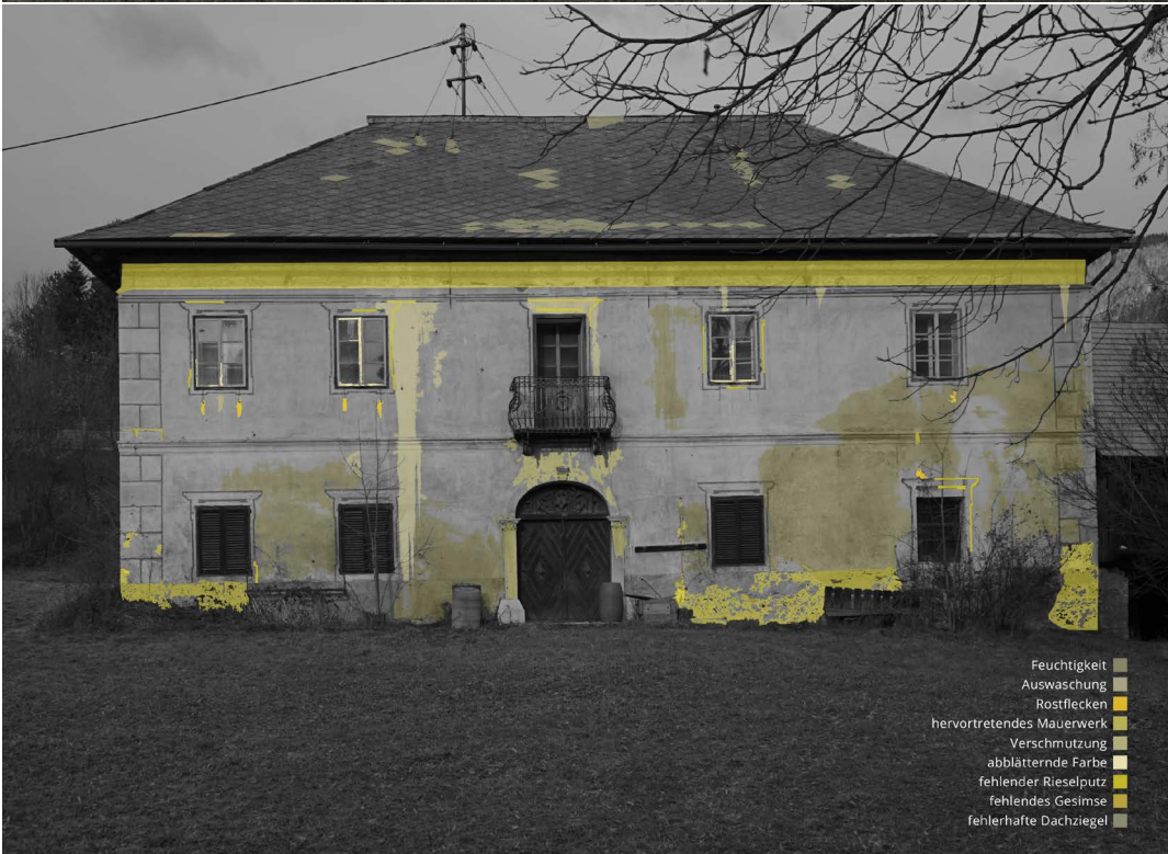
ABB.65: SCHADENSKATASTER SÜDFASSADE
