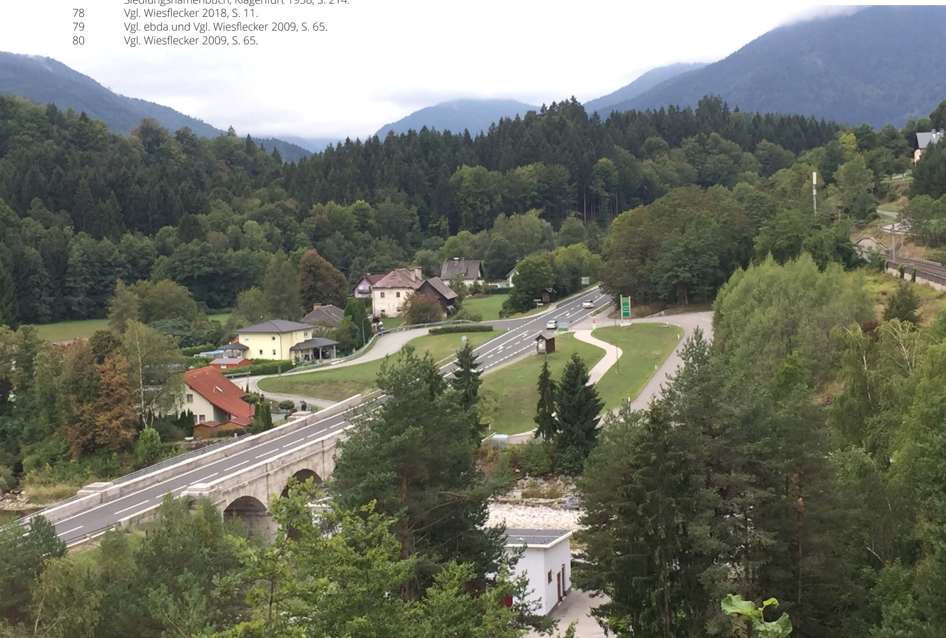
ABB.20: GEWERKENHAUS STOSSAU VON OBEN
