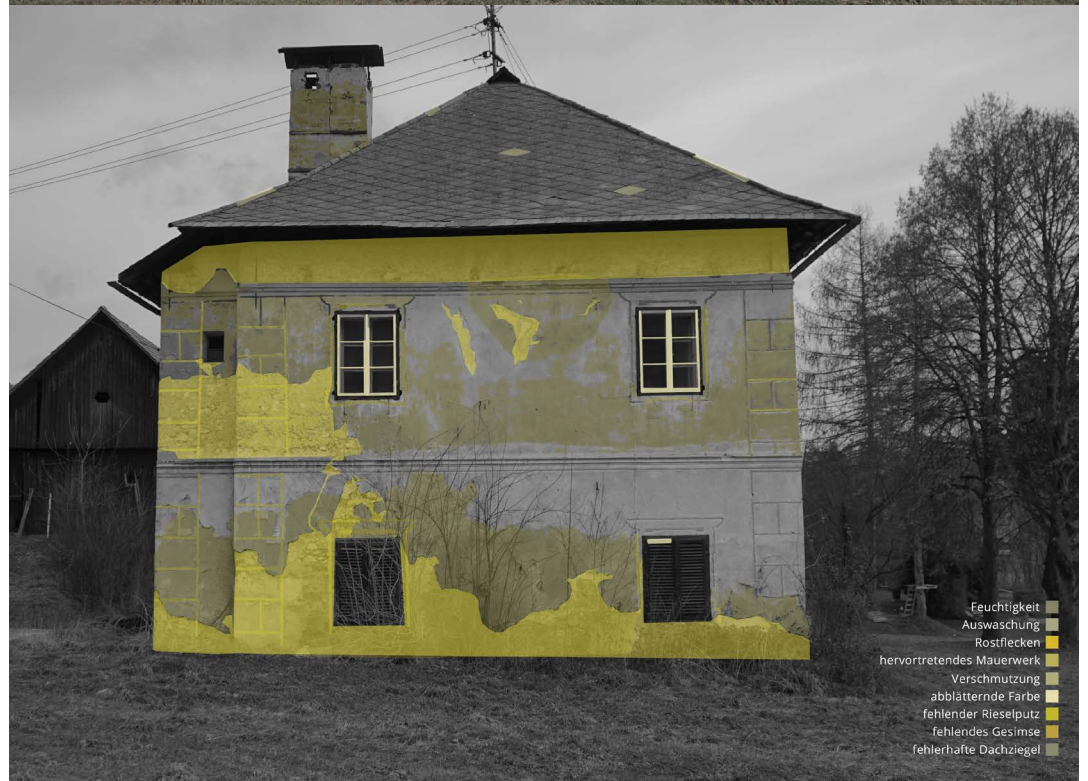
ABB.66: SCHADENSKATASTER WESTFASSADE
