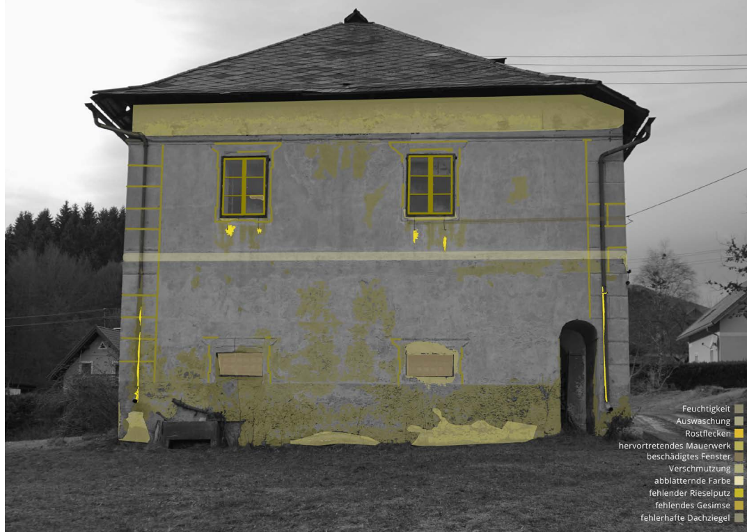
ABB.64: SCHADENSKATASTER OSTFASSADE
