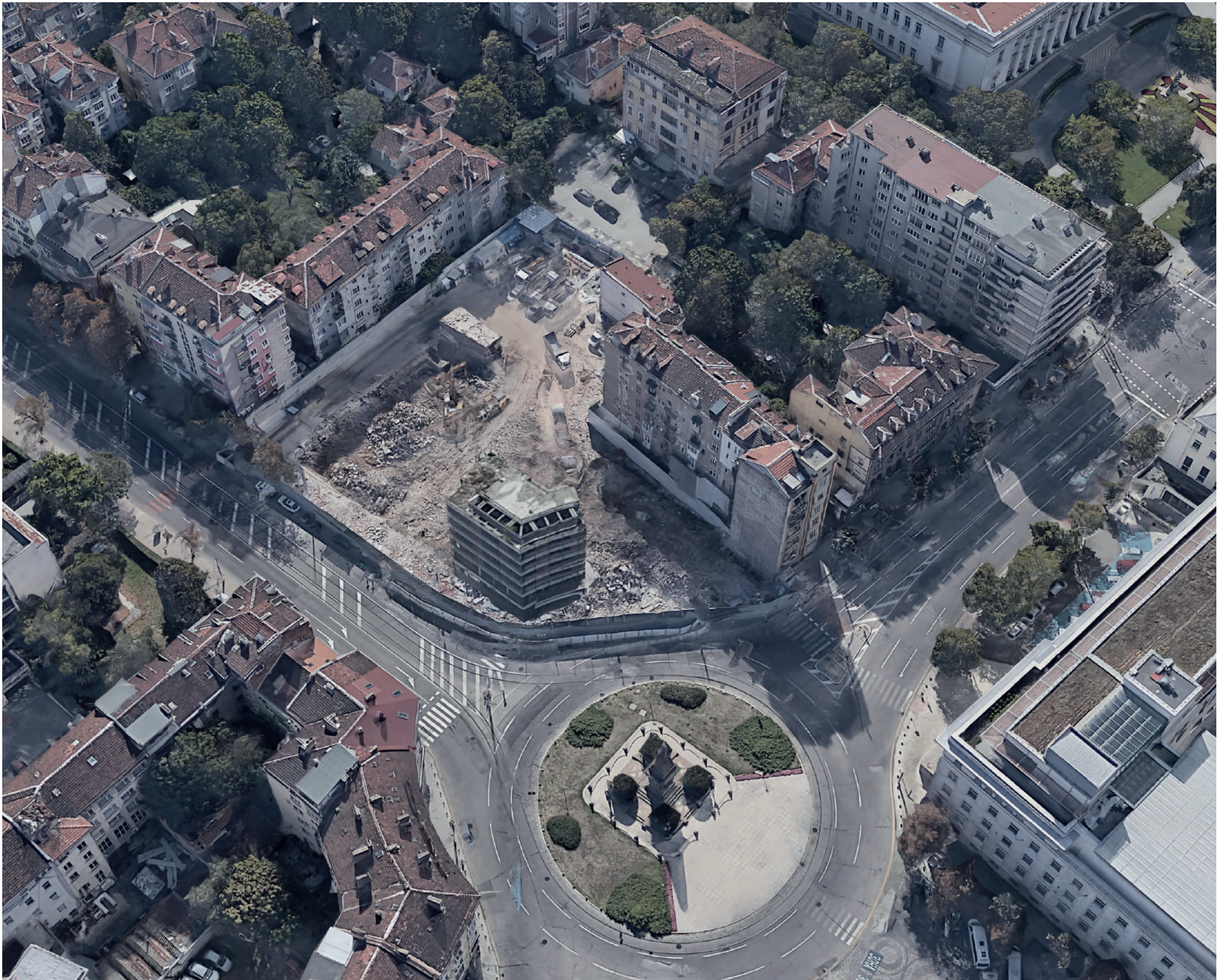
Abb.21 Luftbild Bauplatz(Blickrichtung Südosten)
