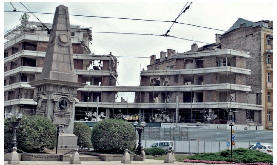
Abb.18 Das Hotelgebäude während der Demolierung
