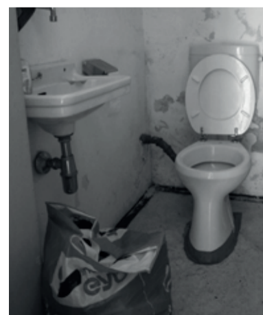
Abb.95 Blick c ehemalige Gästetoilette
