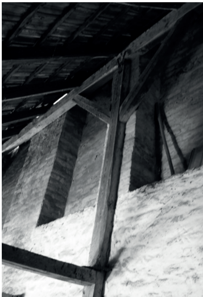
Abb.136 Abgestrebte Stuhlsäule
