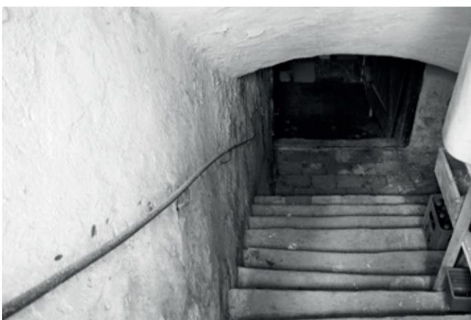
Abb.68 Blick c | Kellerabgang
