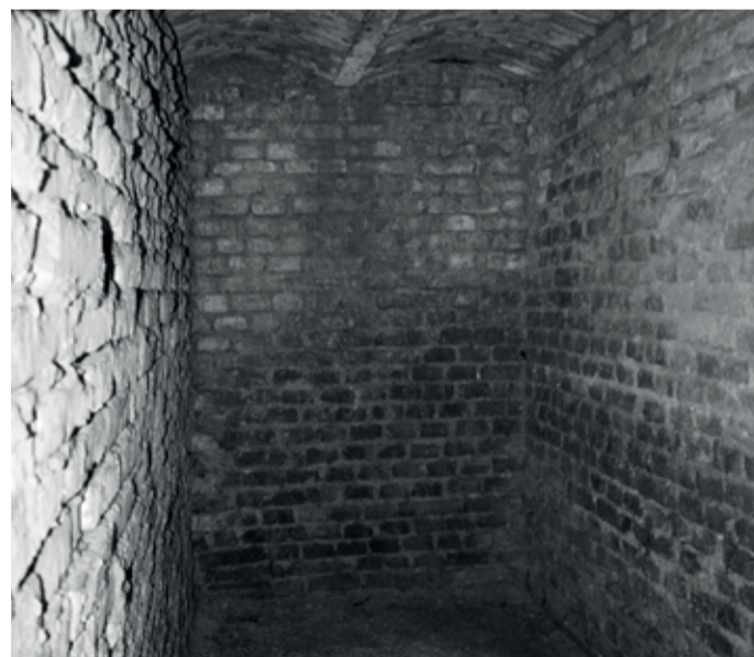
Abb.74 Blick c | Kappengewölbe
