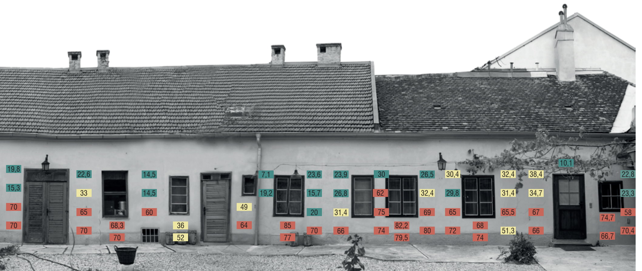
Abb.168 Qualitative Feuchtemessung der Außenflächen
