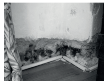
Abb.128 Feuchteschäden | Stelle1
