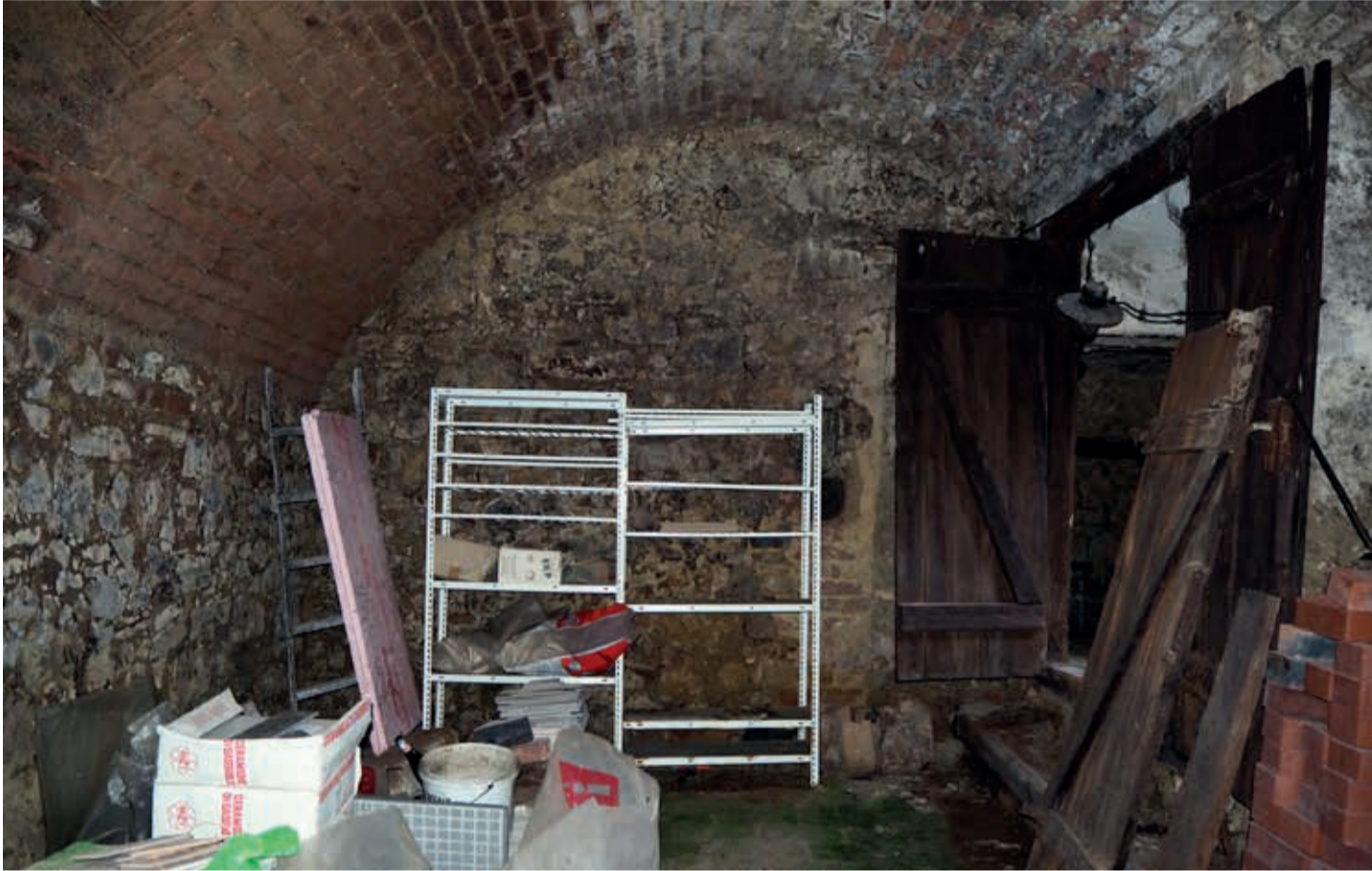
Abb.65 Blick a | Tonnengewölbe | Keller 01
