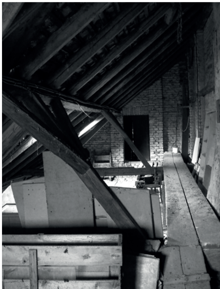
Abb.142 Blick d | Abgestrebter Stuhl
