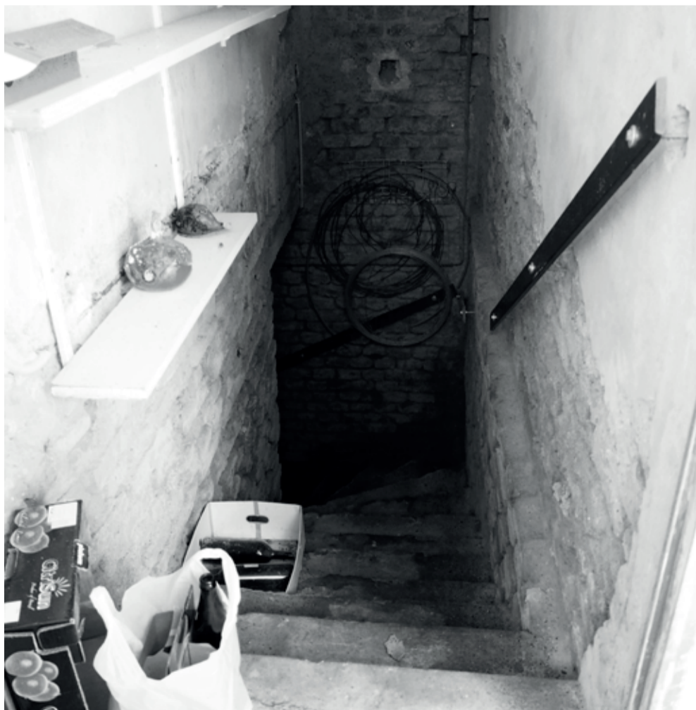
Abb.93 Blick b | Kellerabgang
