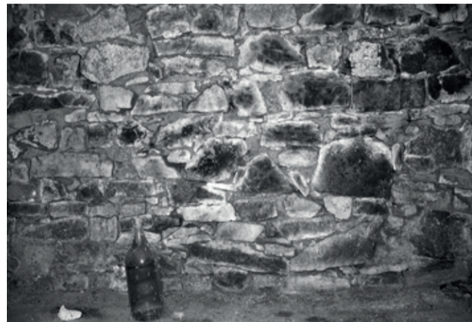
Abb.67 Mischmauerwerk
