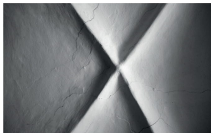
Abb.132 Kreuzgewölbe im Vorzimmer
