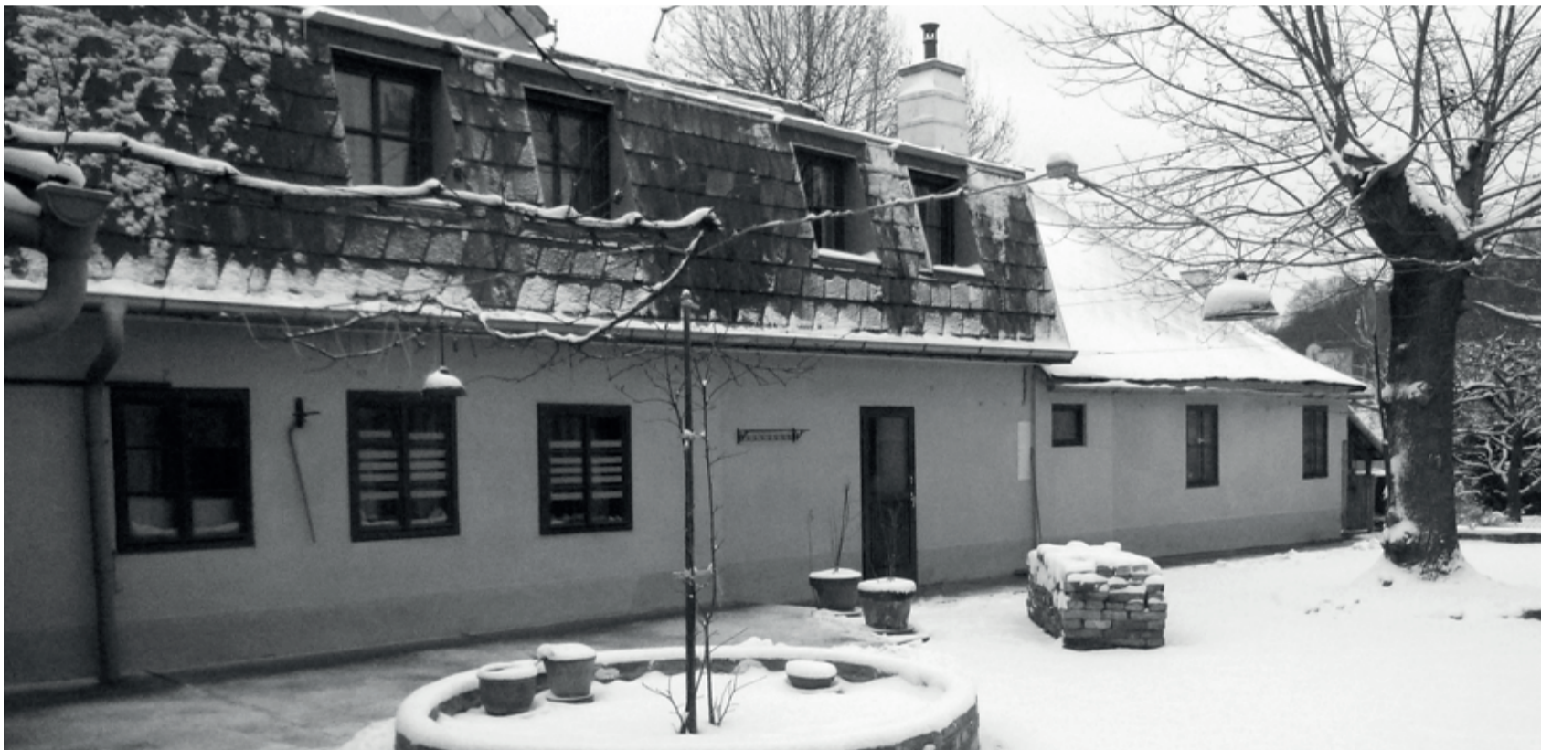
Abb.193 Verdichtung: Der Dachausbau im Ostrakt wurde 1993 durchgeführt.
