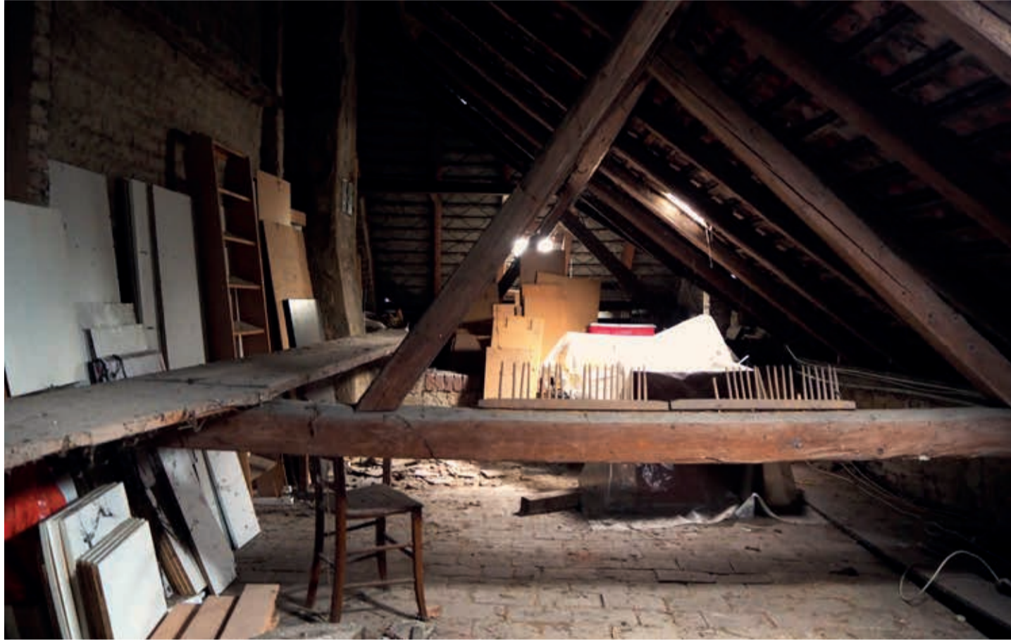
Abb.139 Blick a | Abgestrebter Stuhl | Raum 22
